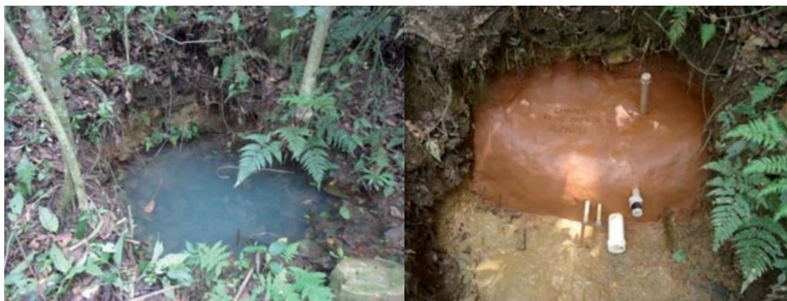
Figura 4: Proteção de mina com a técnica de solo-cimento. Fonte: Costa Alemão (2015).
