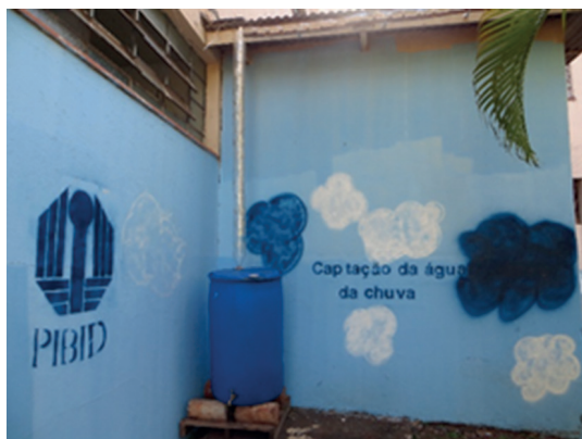
Figura 2: Captação da água da chuva
