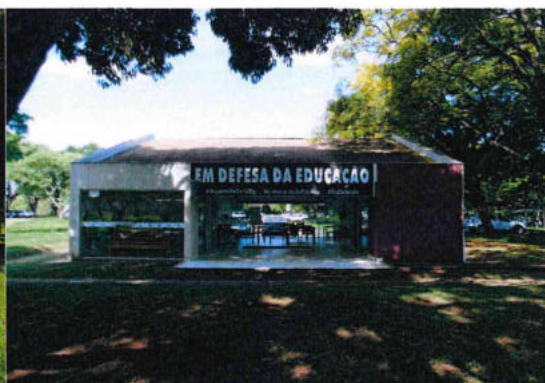
4.2. Cobertura em telhado shingle, com 2 águas.
