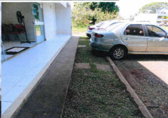
2.10. Calçada perimetral em piso cimentado.
