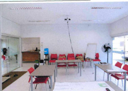
4.11. Paredes internas em gesso acartonado dry wall - Auditório.
