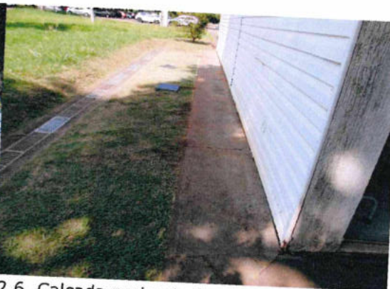
2.6. Calçada perimetral em piso cimentado.
