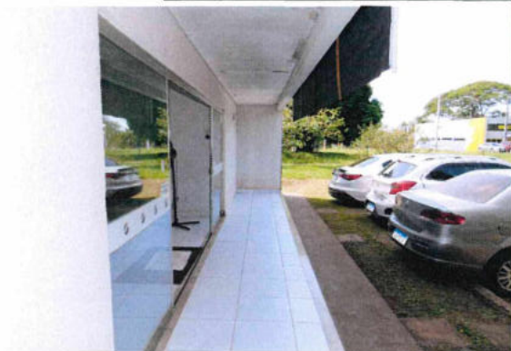
4.3. Forro em gesso acartonado, no beiral da Fachada Leste.
