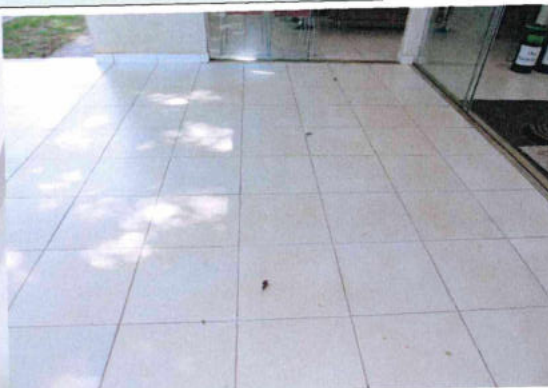
5.3. Piso cerâmico - Varanda.
