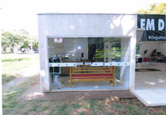
4.18. Fechamento de vidro temperado, na Fachada Oeste.
