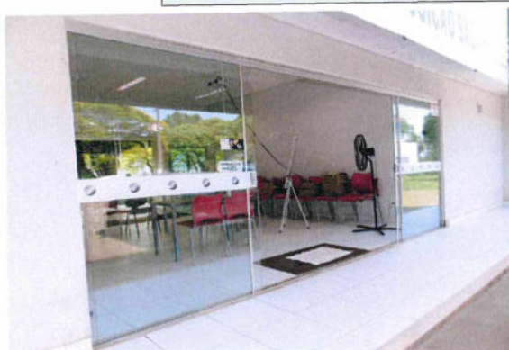
4.16. Porta de vidro temperado, no acesso pela Fachada Leste.
