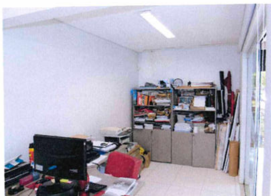
4.12. Paredes internas em gesso acartonado dry wall - Recepção.
