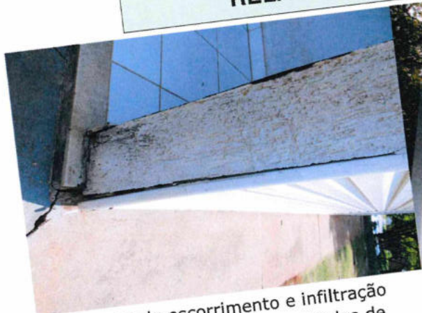
7.4. Marcas de escoamento e infiltração d'água com estufamento na testeira do beiral na Fachada Leste.
