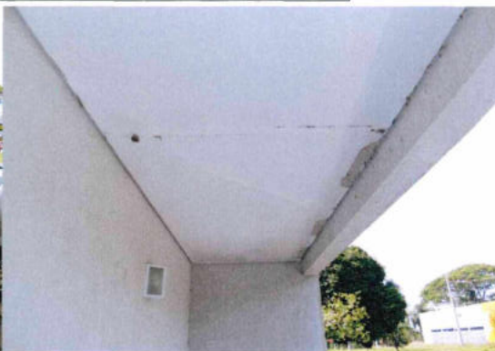
4.4. Forro em gesso acartonado, no beiral da Fachada Leste.
