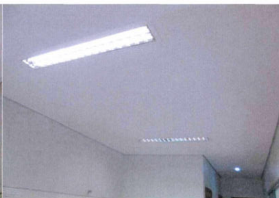
4.6. Forro em gesso acartonado, na Copa.
