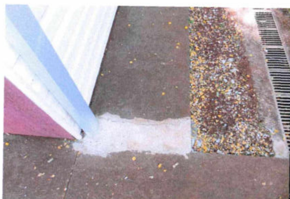
7.49. Condutores d'água pluvial instalados rente à Fachada Sul do imóvel.
