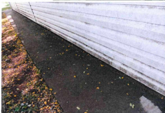
2.9. Calçada perimetral em piso cimentado.
