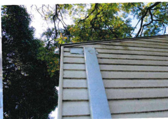
5.5. Condutores verticais aparentes de água pluvial em chapa de aço galvanizado, na Fachada Sul.
