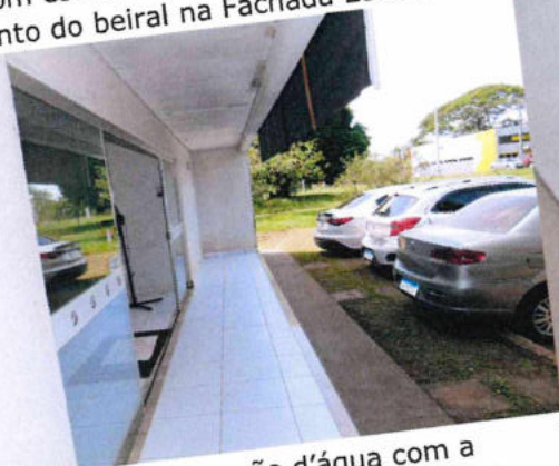
7.6. Marcas de infiltração d'água com a pintura estufada e descascada no forro do beiral na Fachada Leste.
