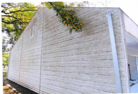
5.4. Condutores verticais aparentes de água pluvial em chapa de aço galvanizado, na Fachada Sul.
