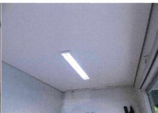
4.9. Forro em gesso acartonado, na Recepção.
