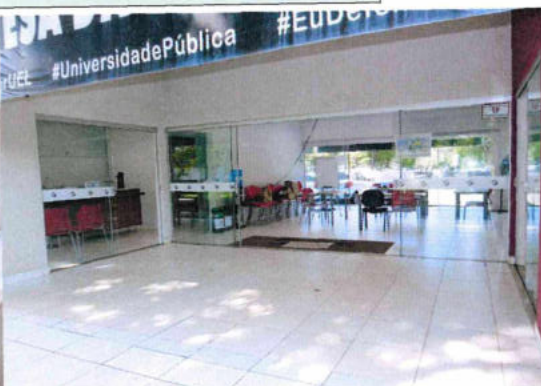
4.17. Portas de vidro temperado, no acesso pela Fachada Oeste.
