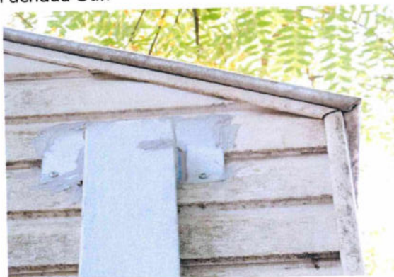
5.6. Condutores verticais aparentes de água pluvial em chapa de aço galvanizado, na Fachada Sul.
