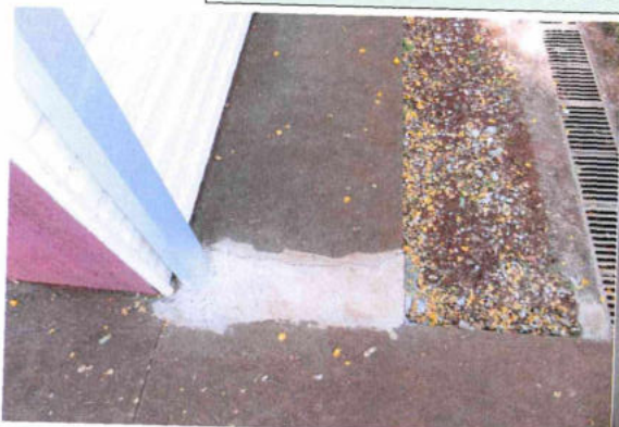
5.8. Condutores verticais aparentes de água pluvial em chapa de aço galvanizado, na Fachada Sul.
