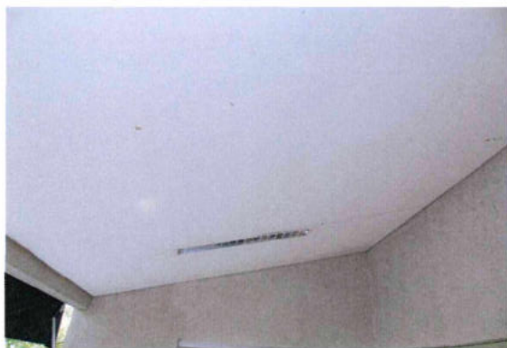
4.5. Forro em gesso acartonado, na Varanda da Fachada Oeste.
