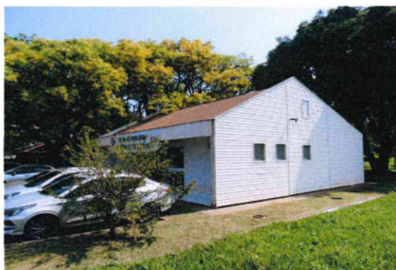
4.1. Cobertura em telhado shingle, com 2 águas.
