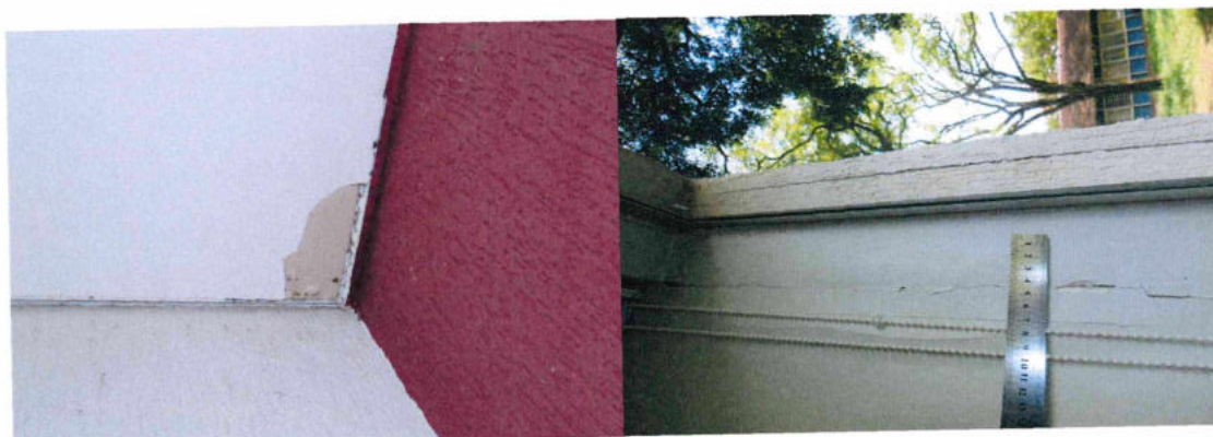
7.26. Trincas verticais nas paredes internas junto ao fechamento em vidro na Fachada Oeste.
