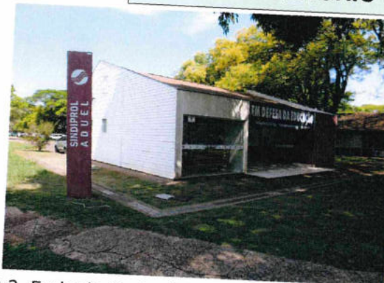
2.3. Fachada Oeste / Fachada Norte.
