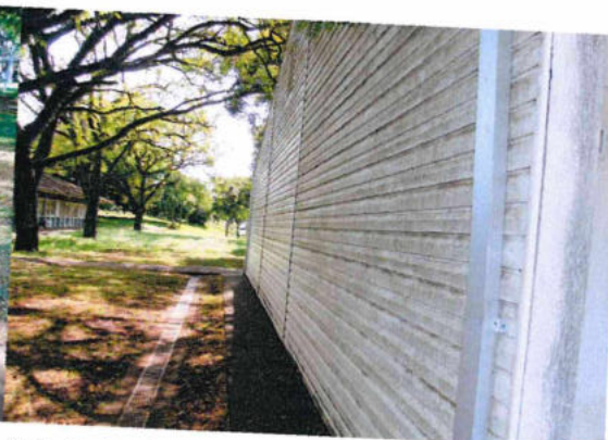
2.8. Calçada perimetral em piso cimentado.
