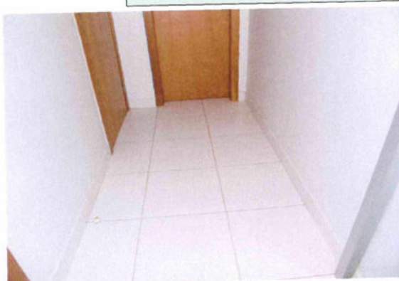
5.2. Piso cerâmico - Circulação.
