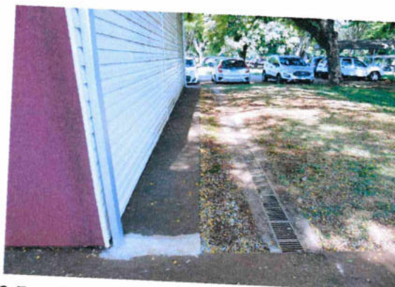
2.7. Calçada perimetral em piso cimentado.
