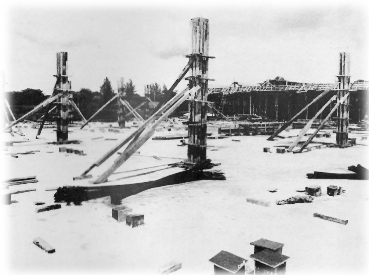
Perobas de concreto: uma velha reivindicação dos estudantes é atendida: Restaurante Universitário no Campus.
