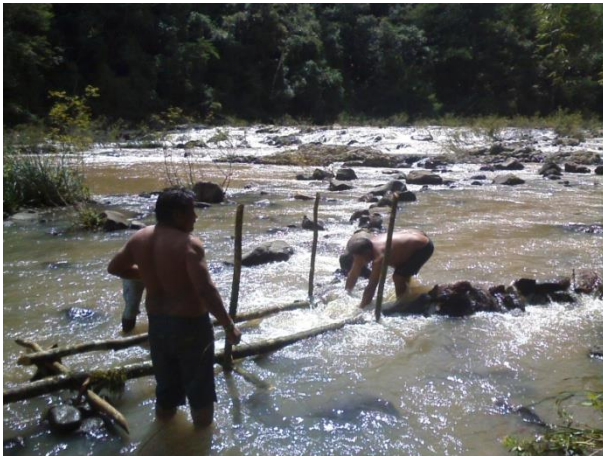
38. Construindo a armação para o pari
