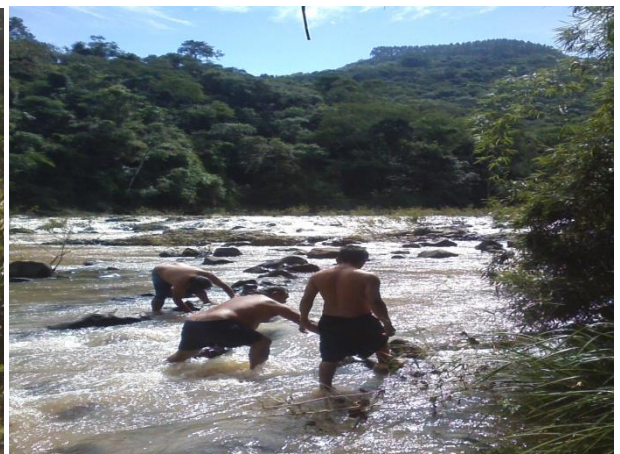
35. Construindo a barragem de pedras
