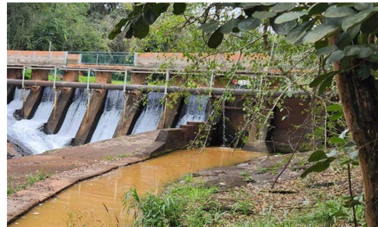
Figura 95 – Barragem, detalhe do ponto de desvio, 2025
