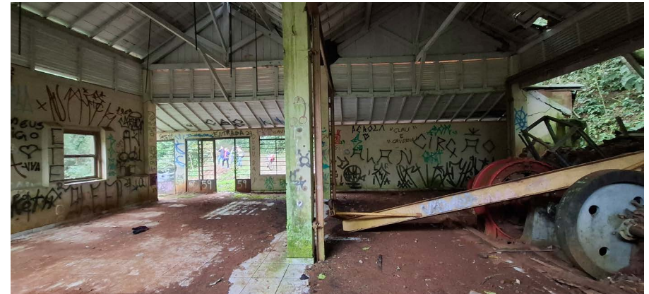
Figura 107 – Vista interna da casa de máquinas, 2025
