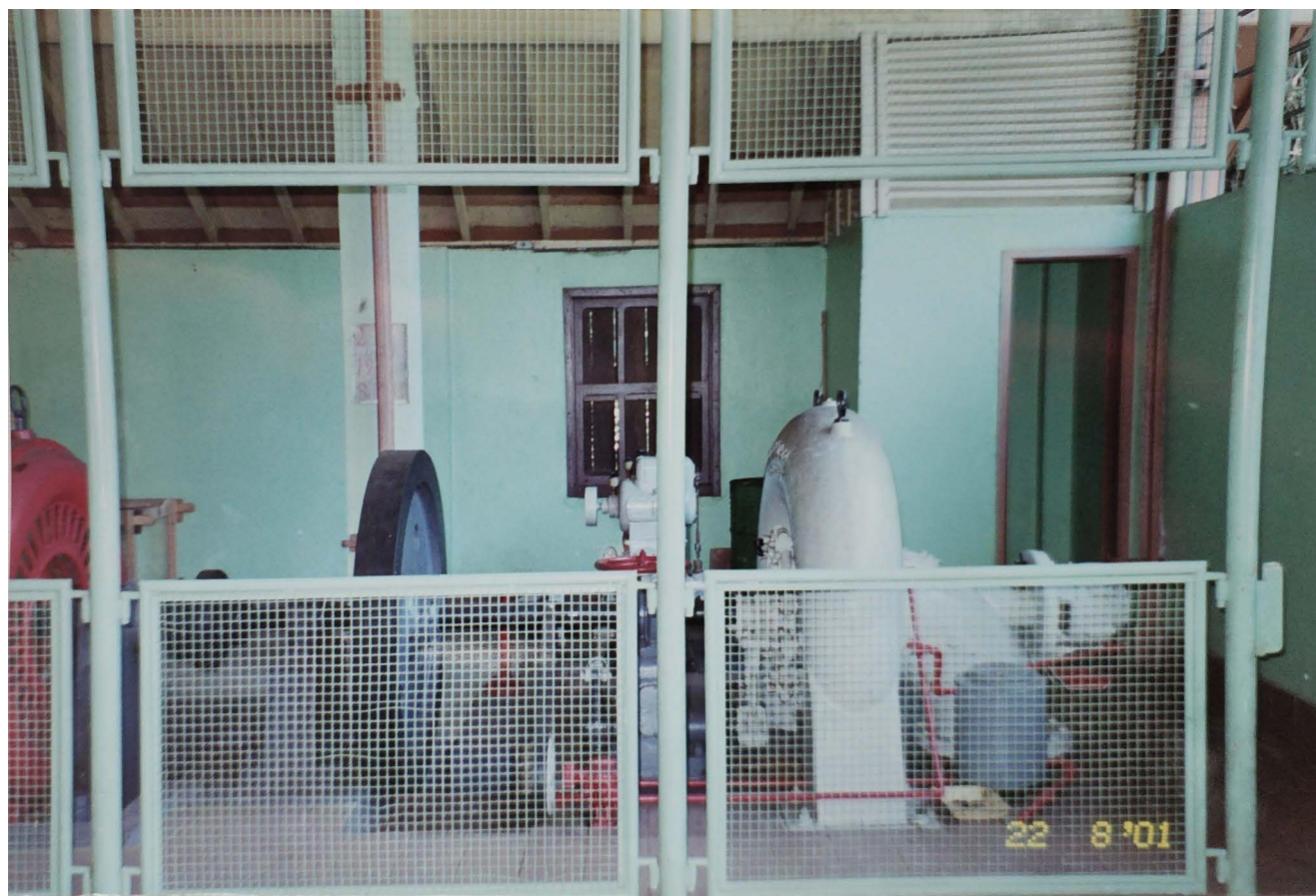
Figura 25 – Turbina (máquina cinza), 2001
