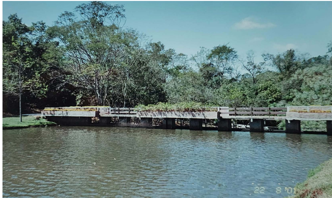
Figura 66 – Barragem da Usina do salto do Cambezinho com canal de adução, 2001
