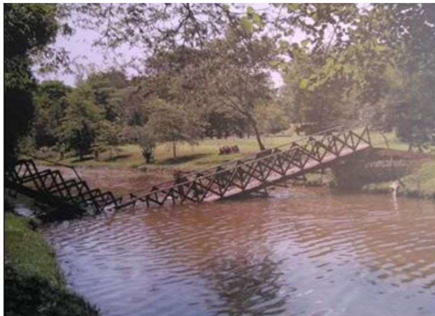
Figura 77 – Danos a ponte do lago no Parque Arthur Thomas, 2011
