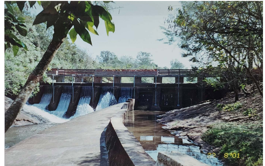
Figura 65 – Barragem da Usina do salto do Cambezinho com canal de adução, 2001
