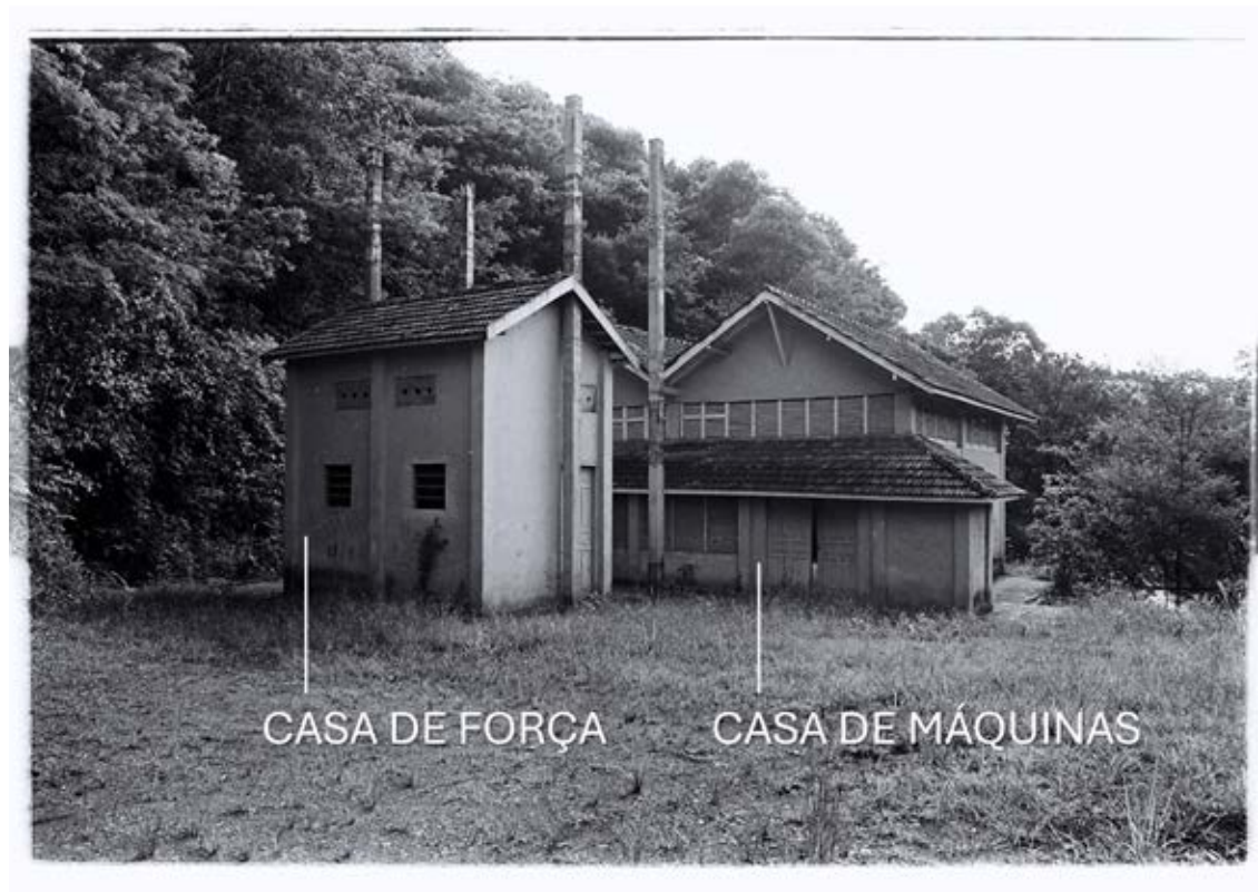
Figura 23 – Casa de máquinas da Usina do salto do Cambezinho, [198-]
