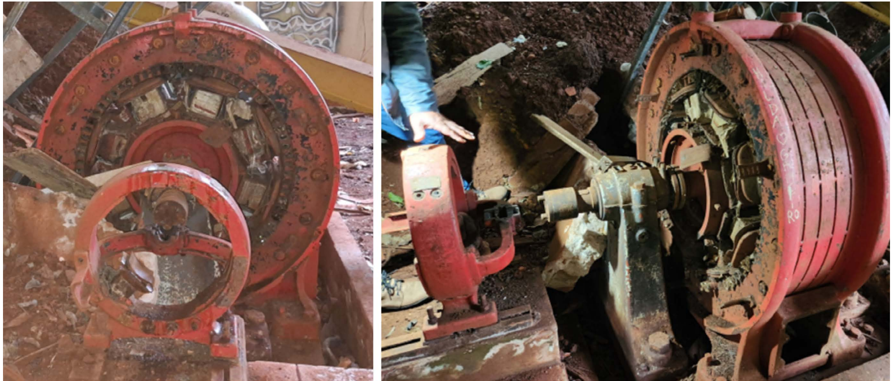
Figura 112 – Gerador síncrono, 2025
