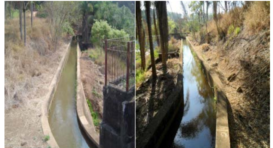
Figura 7 – Canal de adução da Central de Geração Hidrelétrica Armando Barbosa
