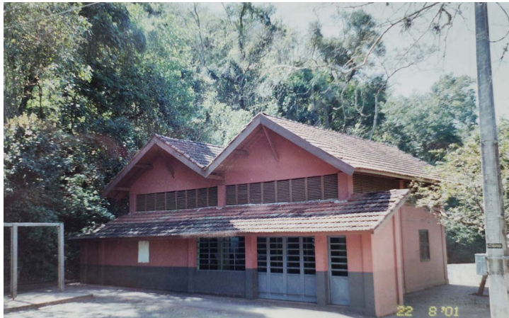
Figura 56 – Fachada principal da casa de máquinas, 2001
