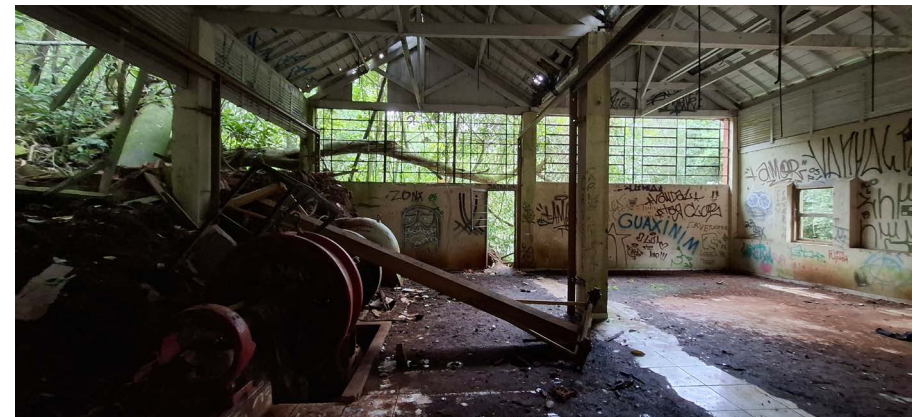
Figura 105 – Vista interna da parede do fundo da casa de máquinas, 2025
