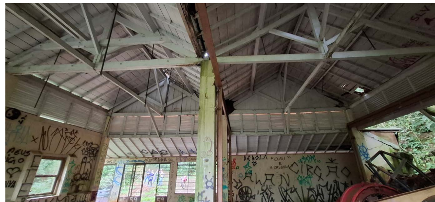
Figura 109 – Cobertura da casa de máquinas, 2025
