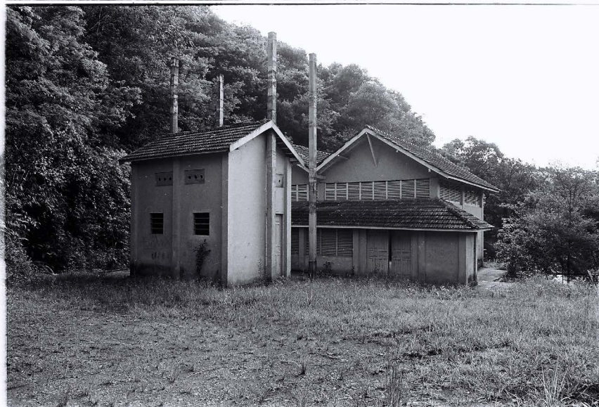
Figura 53 – Casa de máquinas da Usina do salto do Cambezinho, [1985]
