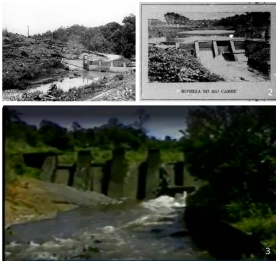
Figura 54 – Barragem da Usina do salto do Cambezinho, comparação [193-], 1940 e 1983
