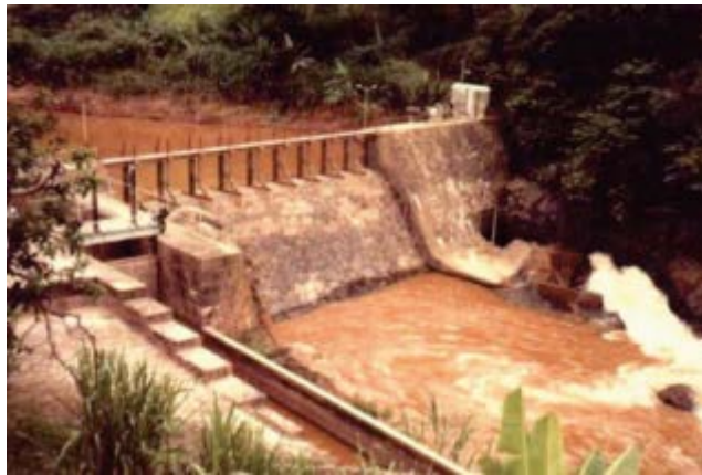
Figura 6 – Barragem da Usina Marmelos Zero
