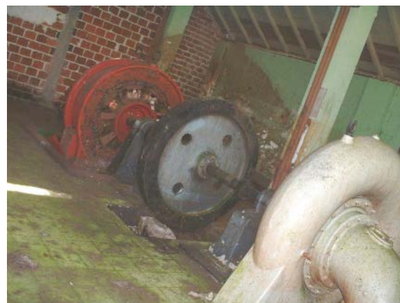
Figura 73 – Equipamentos desativados da usina hidrelétrica, 2008
