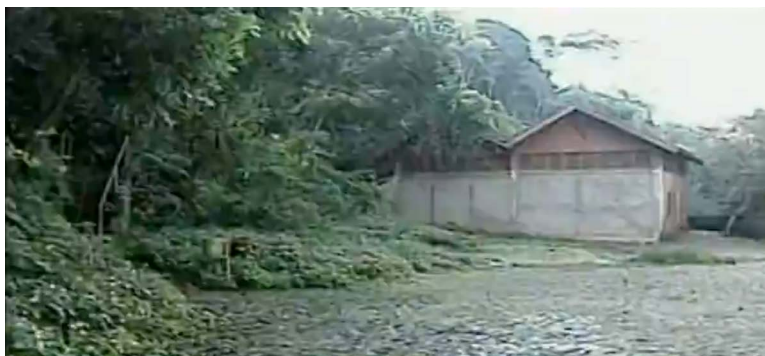
Figura 71 – Usina do salto do Cambezinho recuperada, 2008
