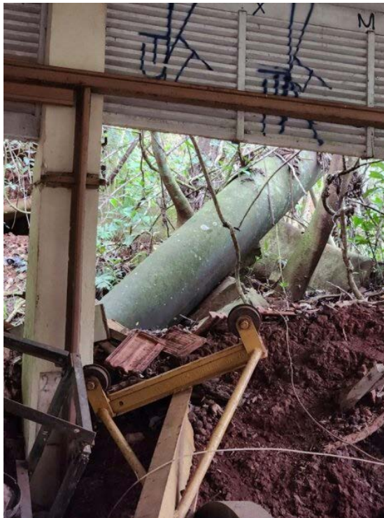
Figura 99 – Estado atual do conduto forçado, 2025
