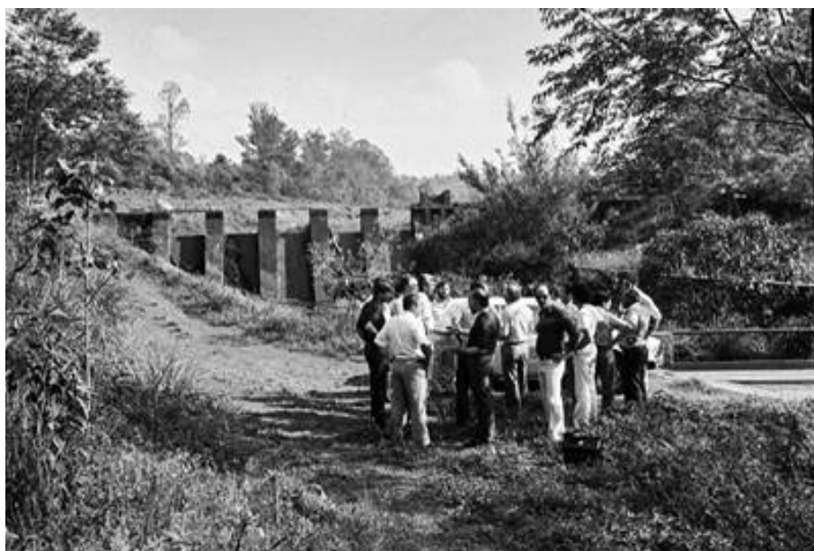
Figura 46 – Barragem da Usina do salto do Cambezinho ao fundo, 1983
