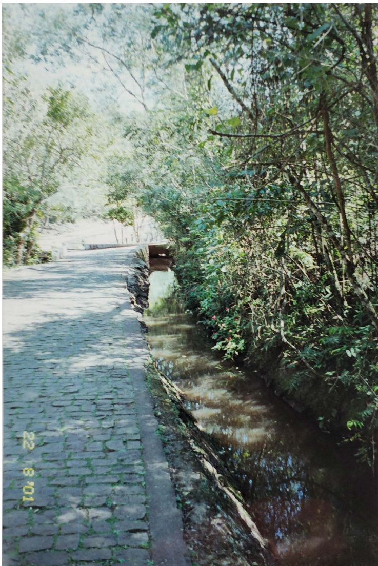
Figura 17 – Canal de adução, 2001
