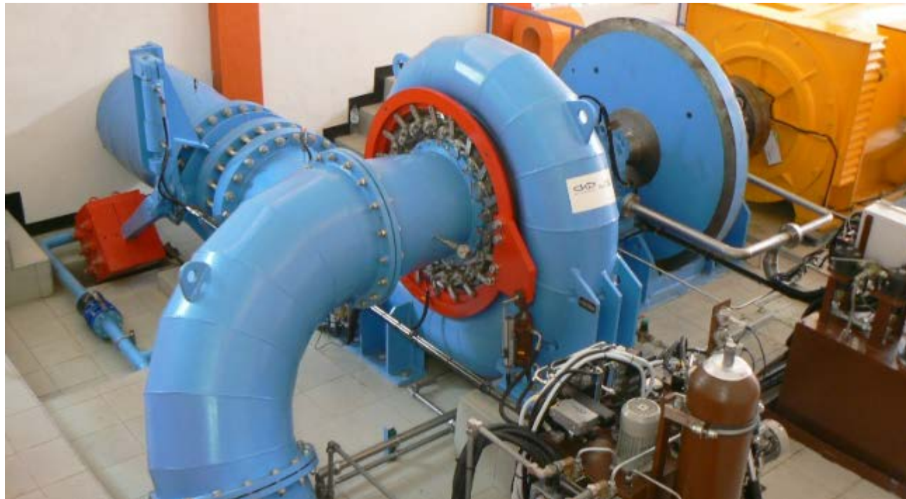
Figura 26 – Exemplo de turbina Francis
