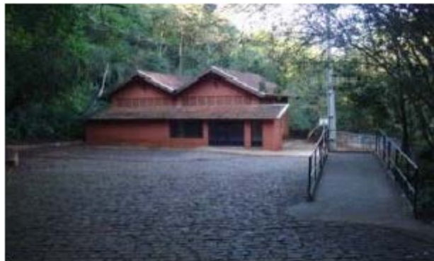
Figura 79 – Fachada principal da casa de máquinas, 2015
