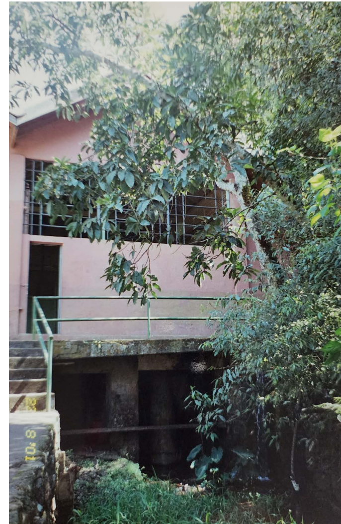
Figura 28 – Fachada posterior da casa de máquinas onde havia o canal de fuga abaixo, 2001
