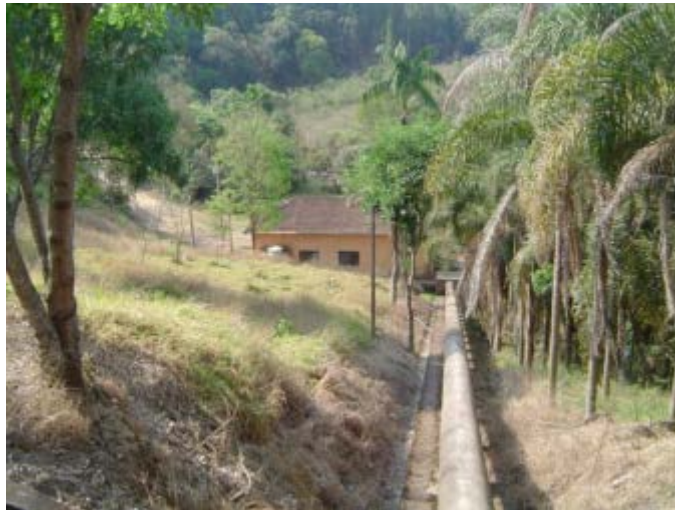
Figura 10 – Conduto forçado da Central de Geração Hidrelétrica Armando Barbosa
