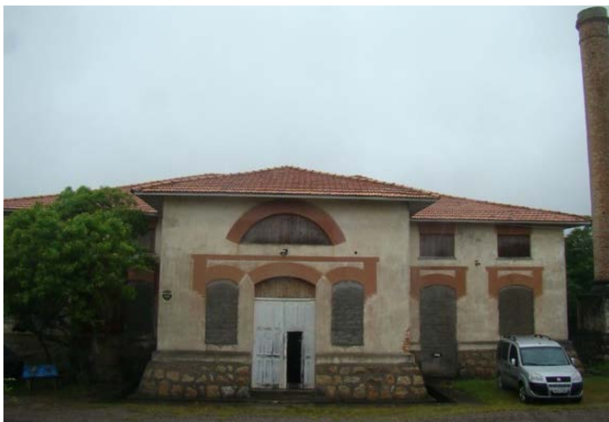
Figura 173 – Complexo da Usina Termelétrica
