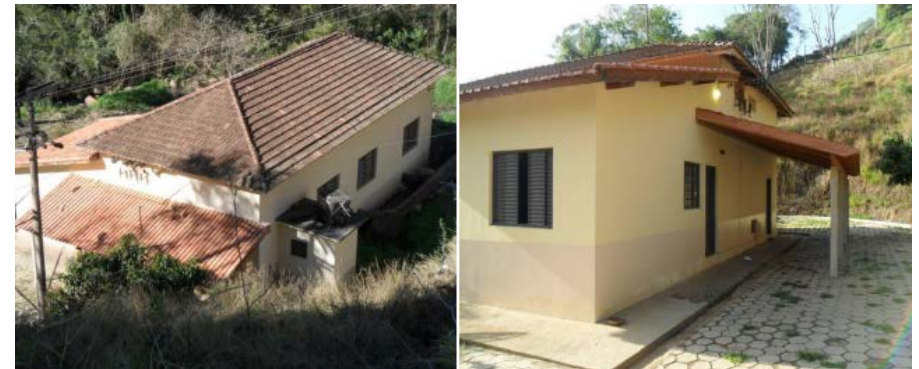
Figura 11 – Casa de máquinas da Central de Geração Hidrelétrica Armando Barbosa
