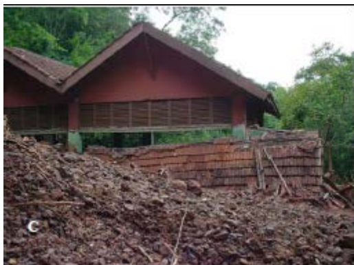
Figura 69 – Soterramento da Usina do salto do Cambezinho, 2004
