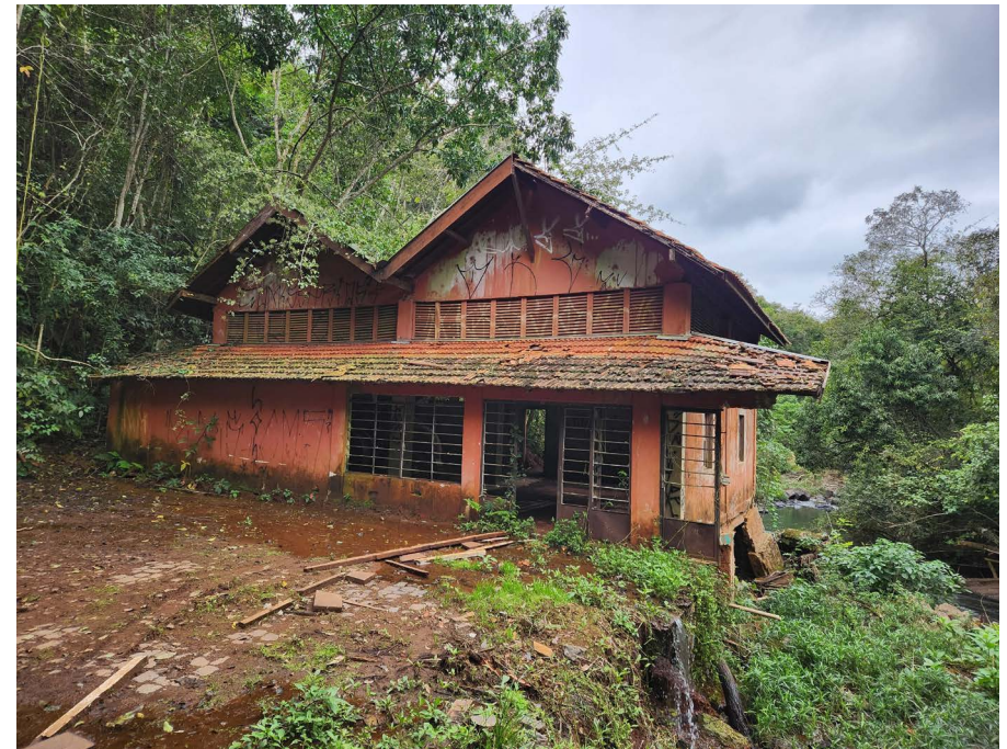
Figura 1 – Estrutura remanescente da Casa de Máquinas da Usina do salto do Cambezinho
