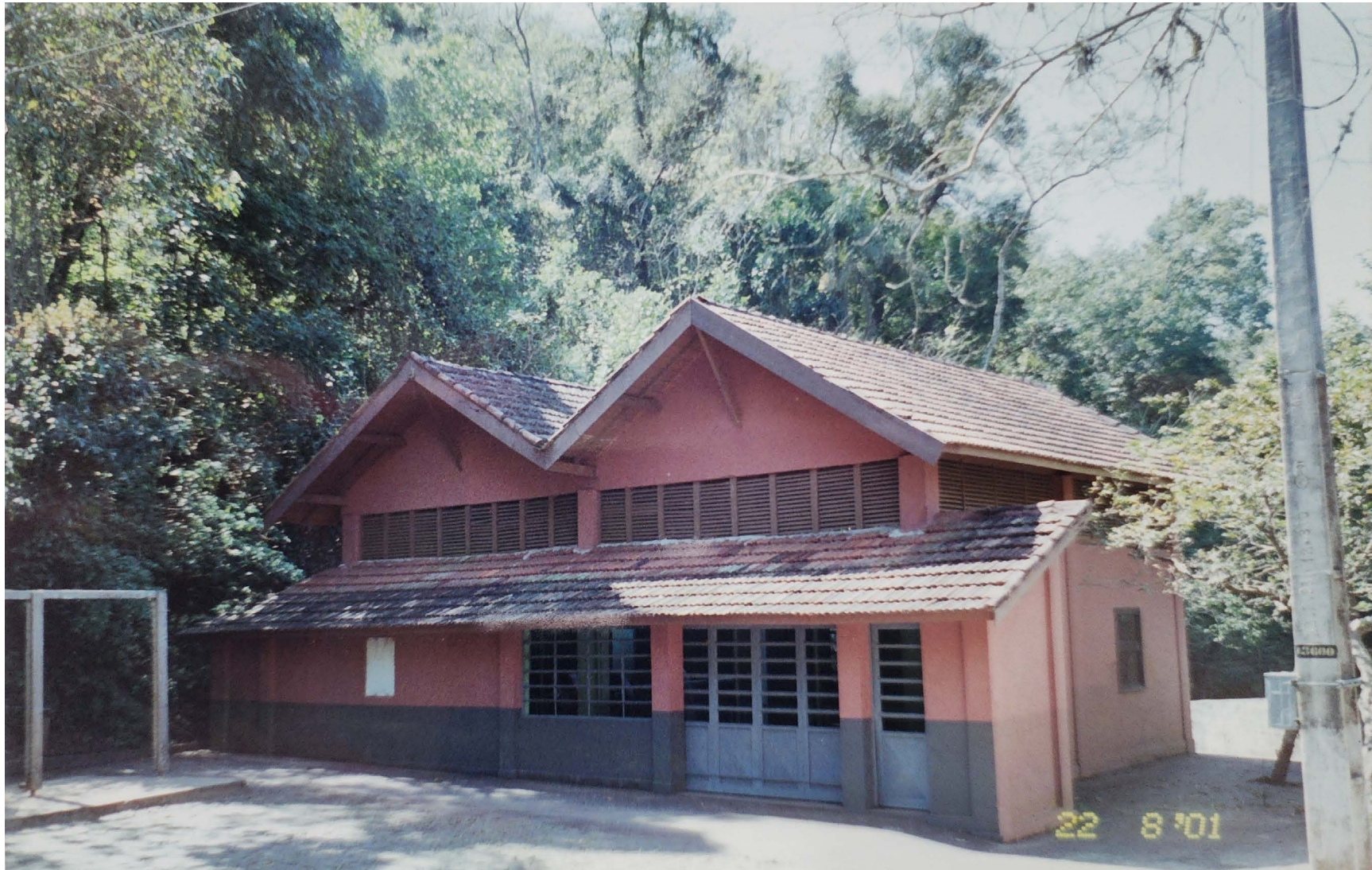
Figura 22 – Fachada principal da casa de máquinas, 2001
