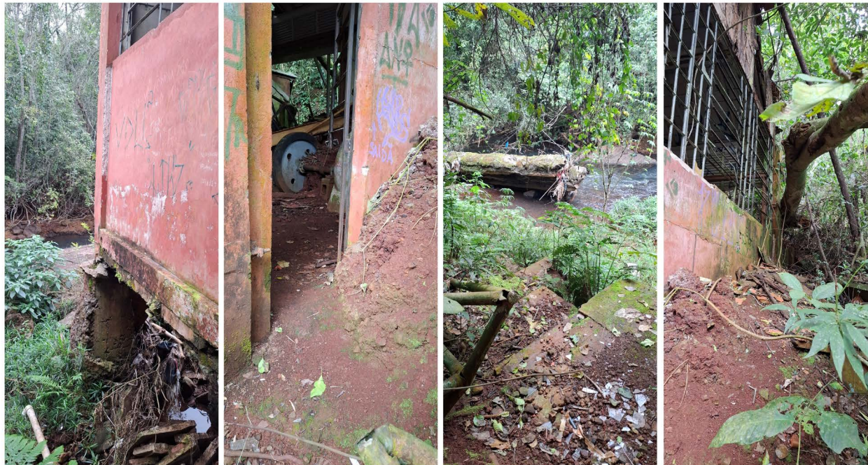
Figura 103 – Fundo da casa de máquinas, 2025
