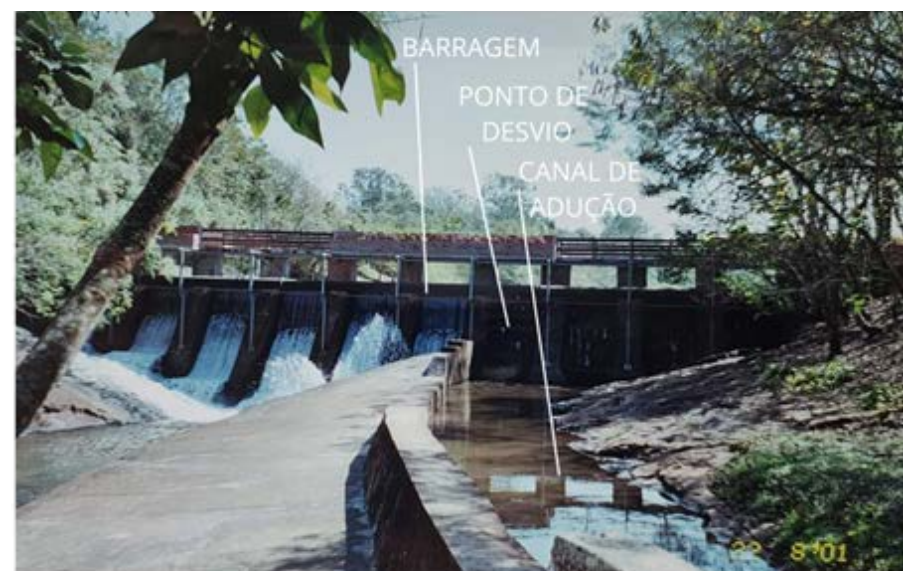
Figura 16 – Canal de adução chegando na barragem da Usina do salto do Cambezinho, 2001
