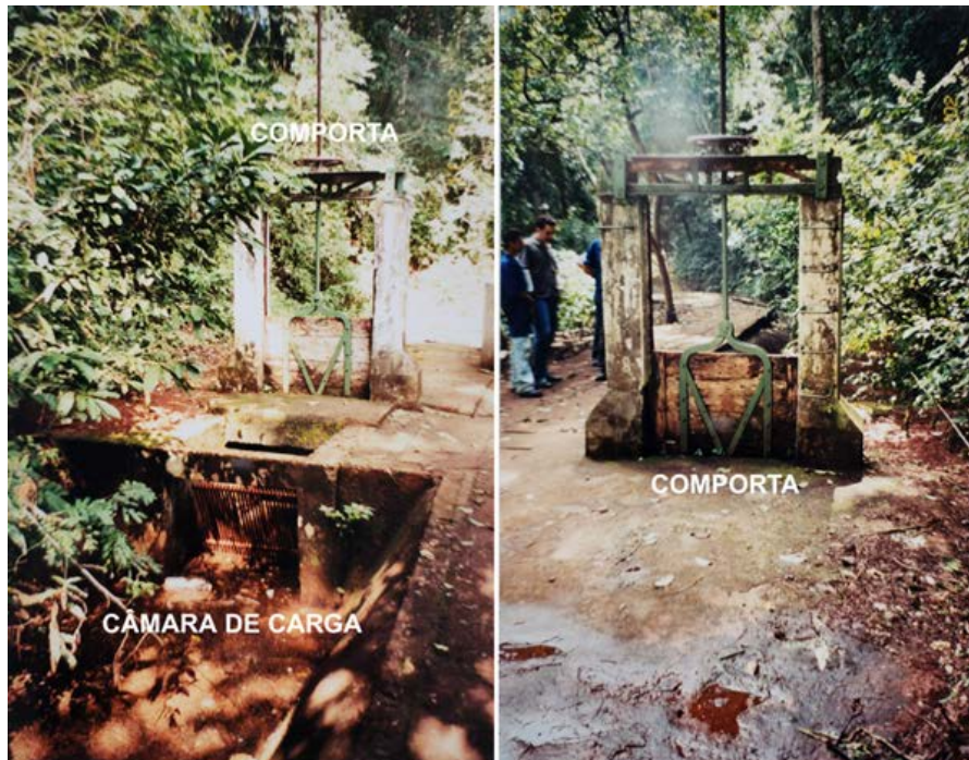
Figura 18 – Câmara de carga e comporta, 2001
