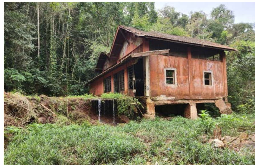
Figura 101 – Casa de máquinas atualmente, 2025
