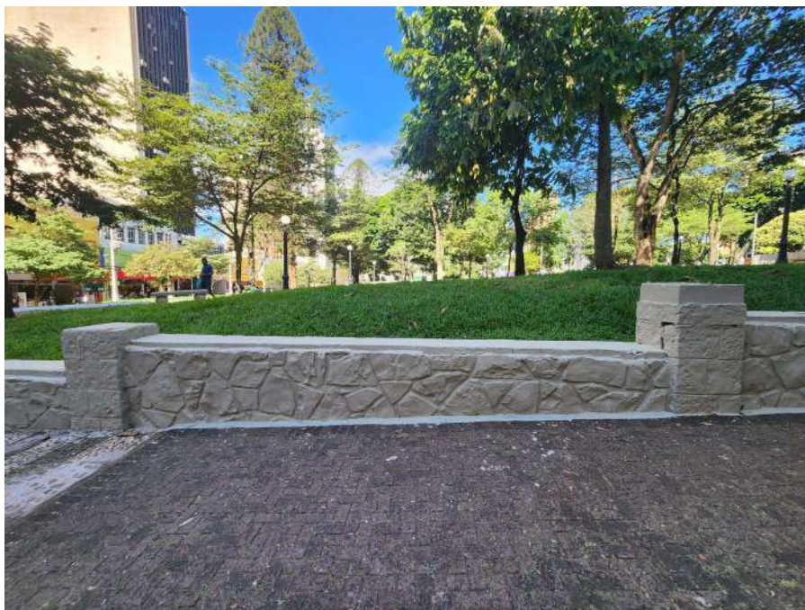
Figura 274 – Muro de arrimo
