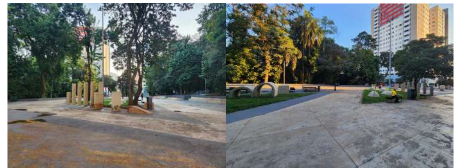
Figura 317 – Pintura atual desgastada
