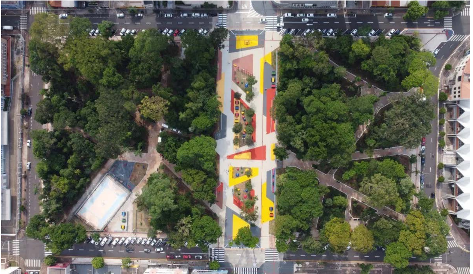
Figura 234 – Vista aérea do Bosque com as obras de revitalização concluídas
