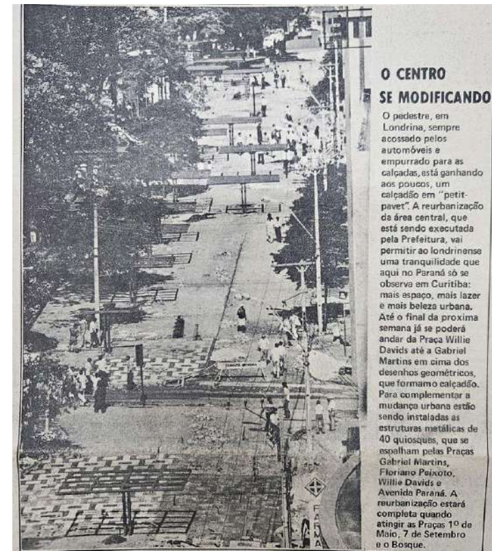
Figura 74 – Reportagem sobre as obras no Calçadão, 28 de outubro de 1977
