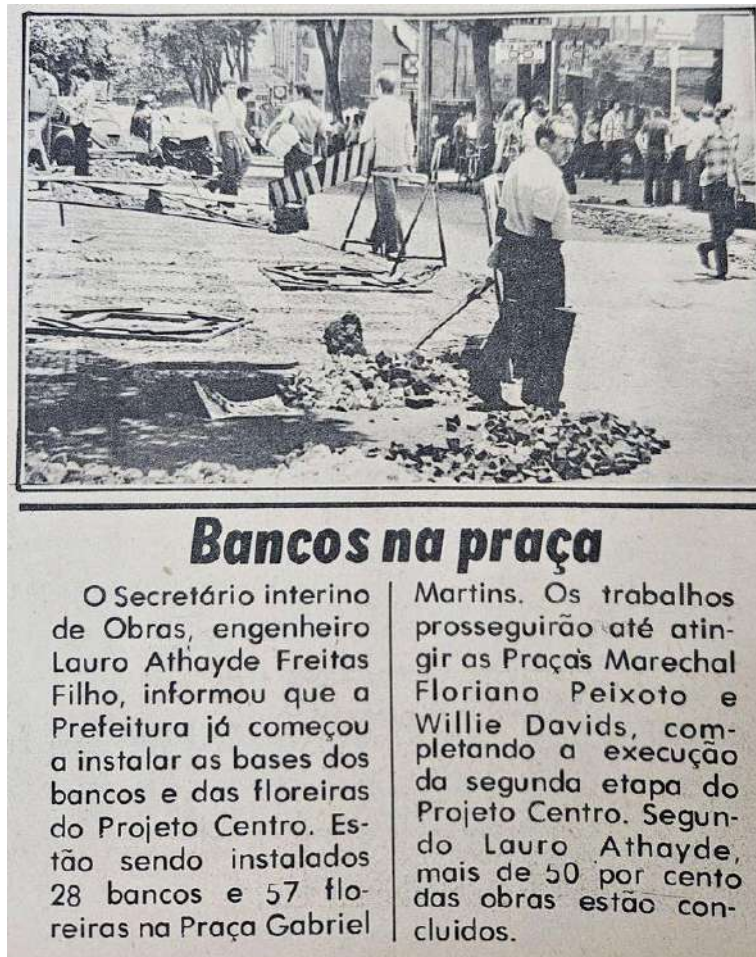
Figura 75 – Reportagem sobre o início da instalação dos bancos, 2 de novembro de 1977
