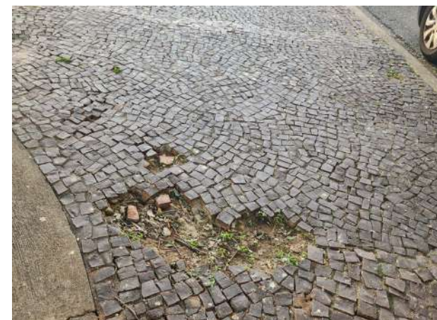
Figura 351 – Situação atual da calçada da Praça Sete de Setembro
