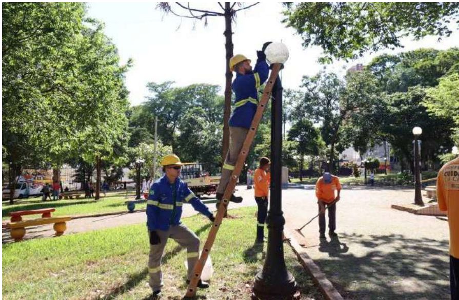
Figura 239 – Manutenção nas luminárias da Praça Marechal Floriano Peixoto
