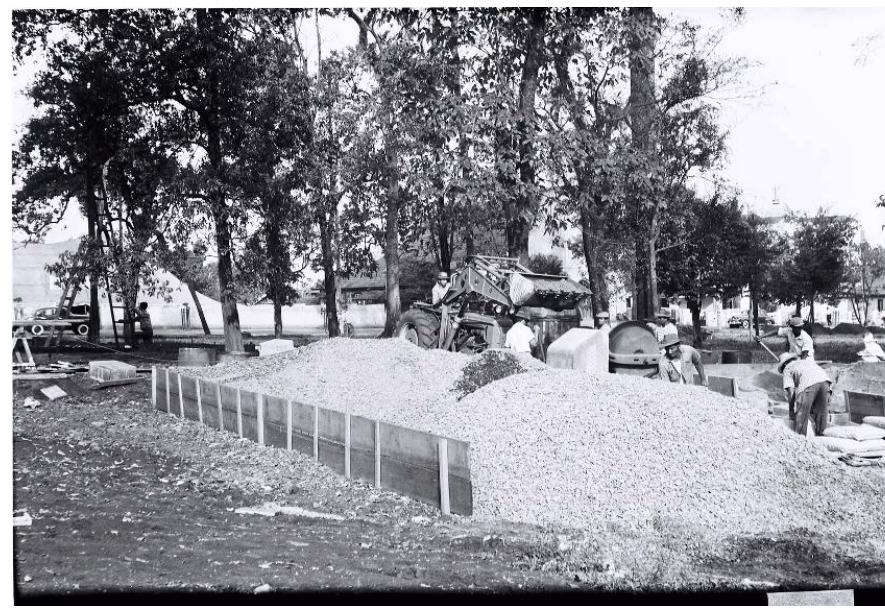
Figura 99 – Obras no Bosque Marechal Cândido Rondon
