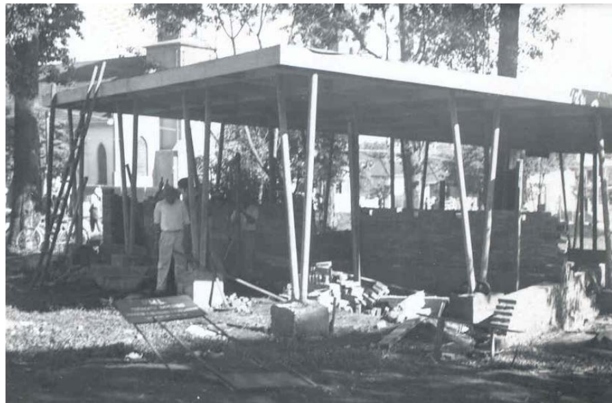
Figura 104 – Obras no Bosque Marechal Cândido Rondon, possivelmente no banheiro
