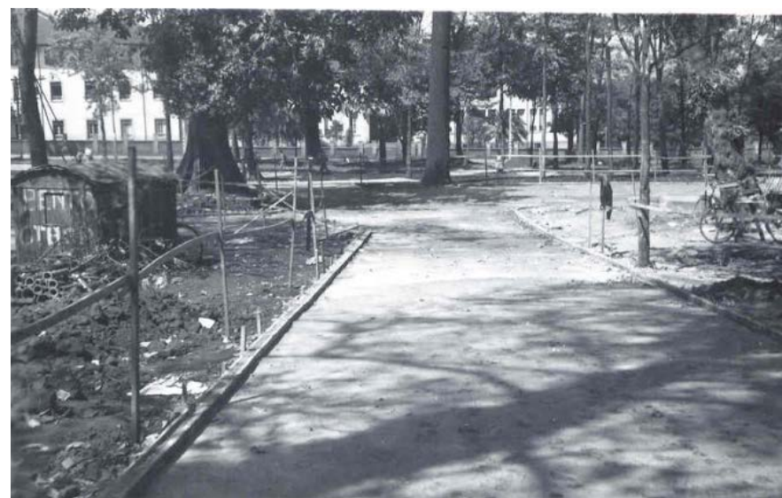
Figura 101 – Obras no Bosque Marechal Cândido Rondon
