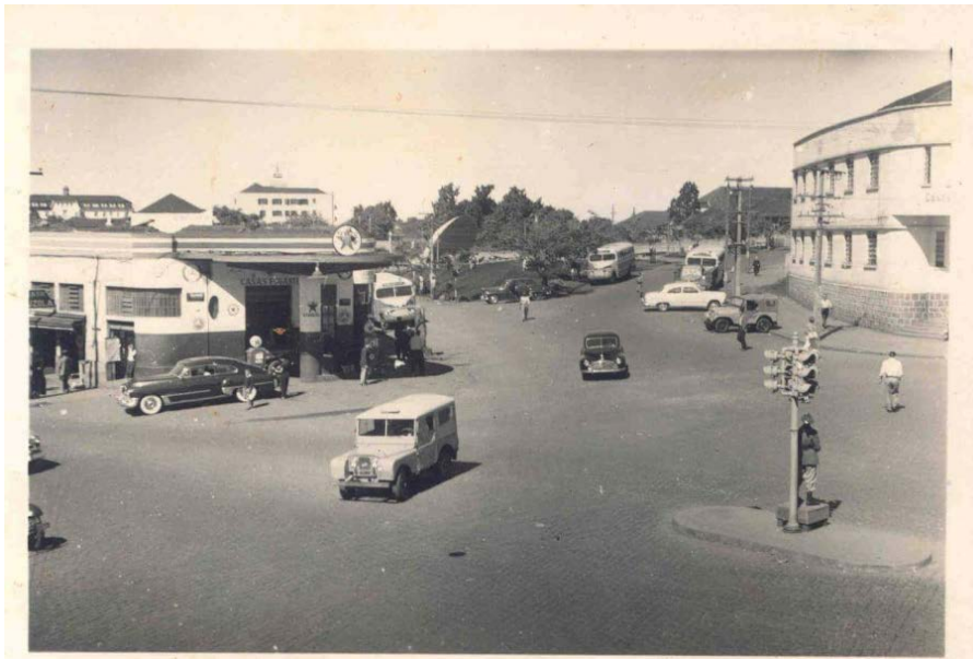
Figura 91 – Revitalização da Praça Primeiro de Maio e construção da Concha Acústica, 1957
