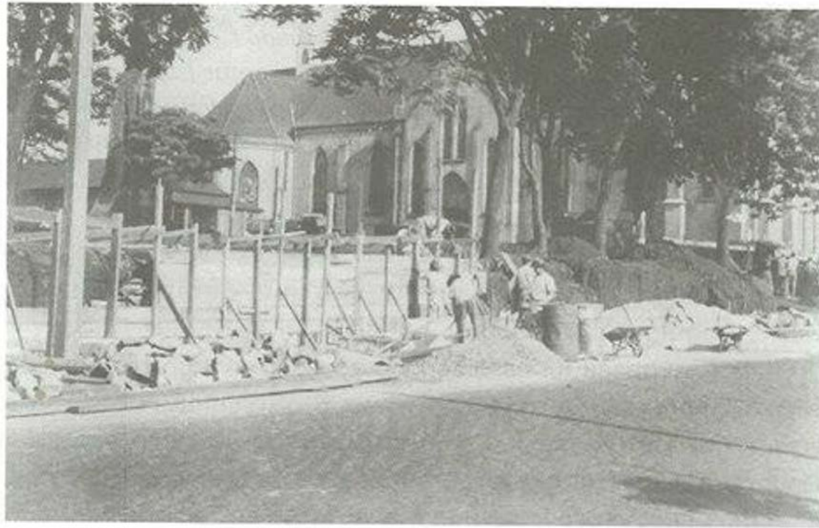
Figura 51 – Construção do muro de arrimo do Bosque Marechal Cândido Rondon, [1938–194-]
