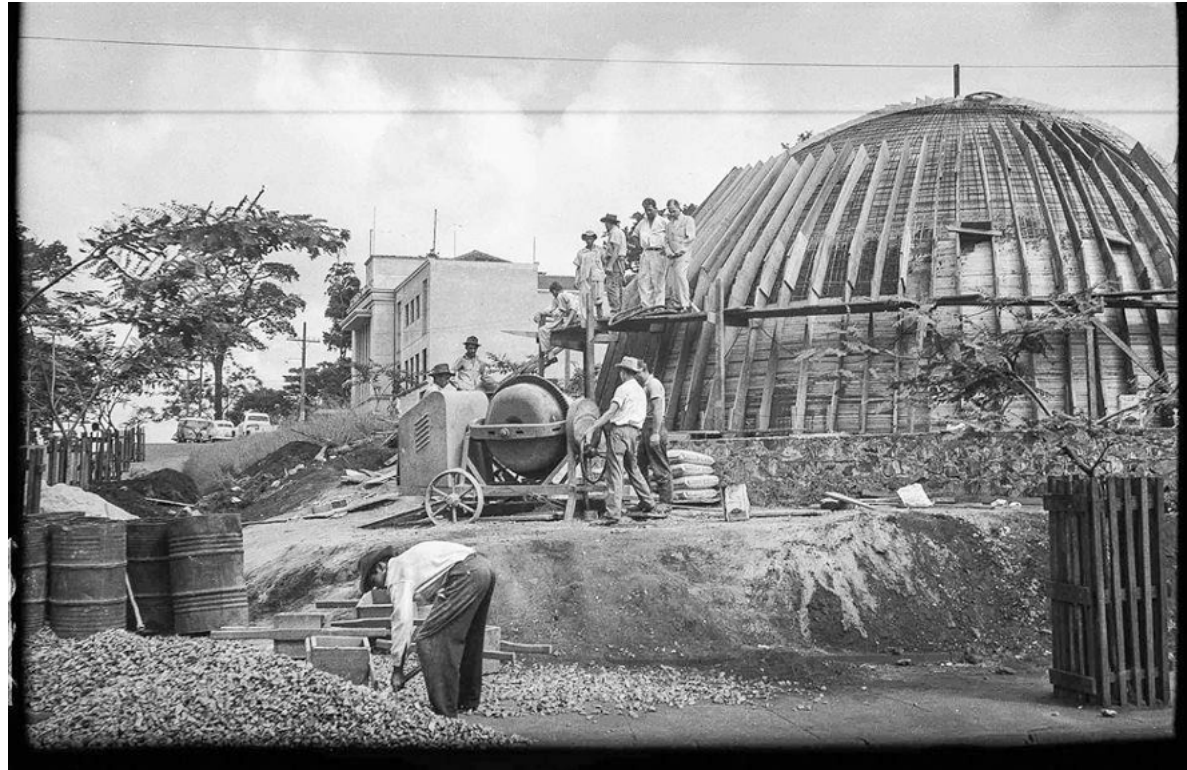
Figura 93 – Revitalização da Praça Primeiro de Maio e construção da Concha Acústica, 1957
