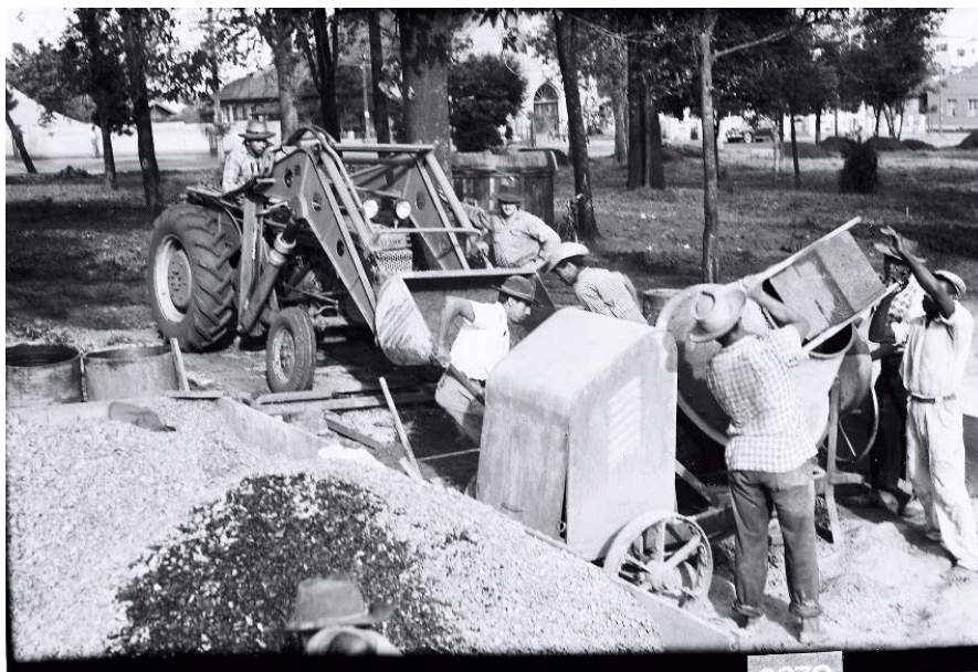
Figura 98 – Obras no Bosque Marechal Cândido Rondon
