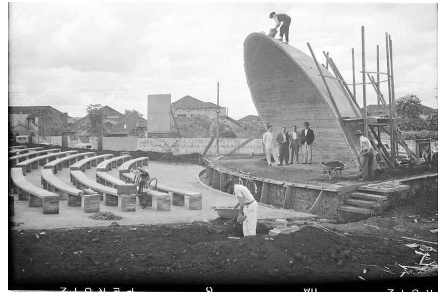
Figura 92 – Revitalização da Praça Primeiro de Maio e construção da Concha Acústica, 1957
