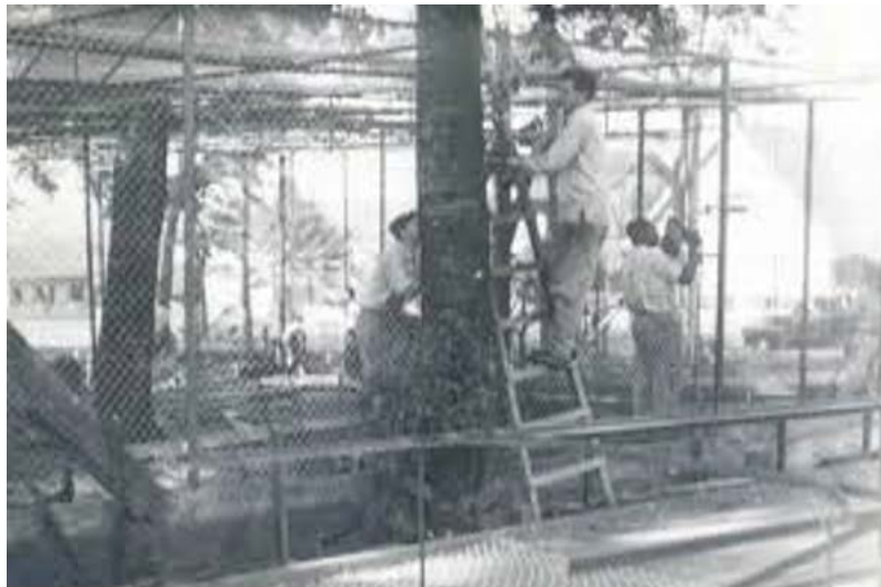
Figura 102 – Obras no Bosque Marechal Cândido Rondon
