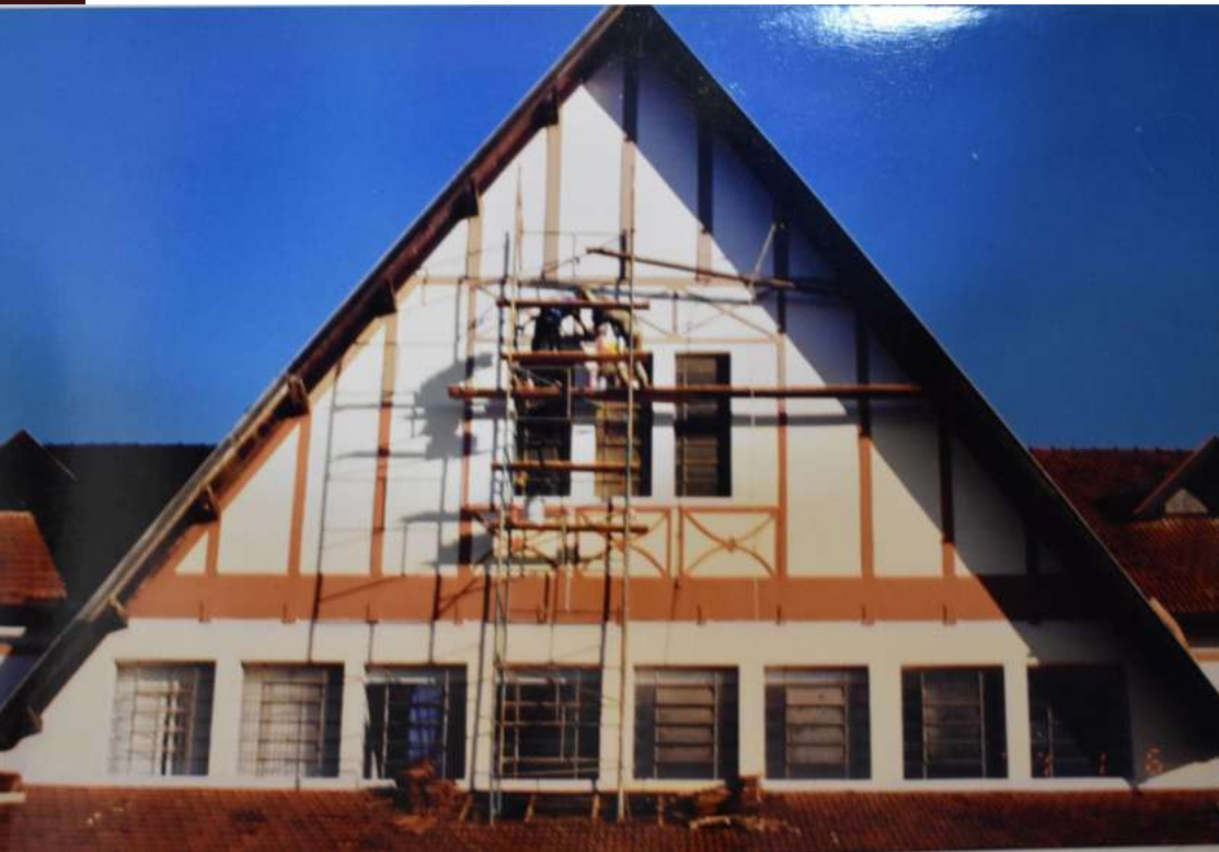
Figura 123 - Pintura da fachada, 1999.
