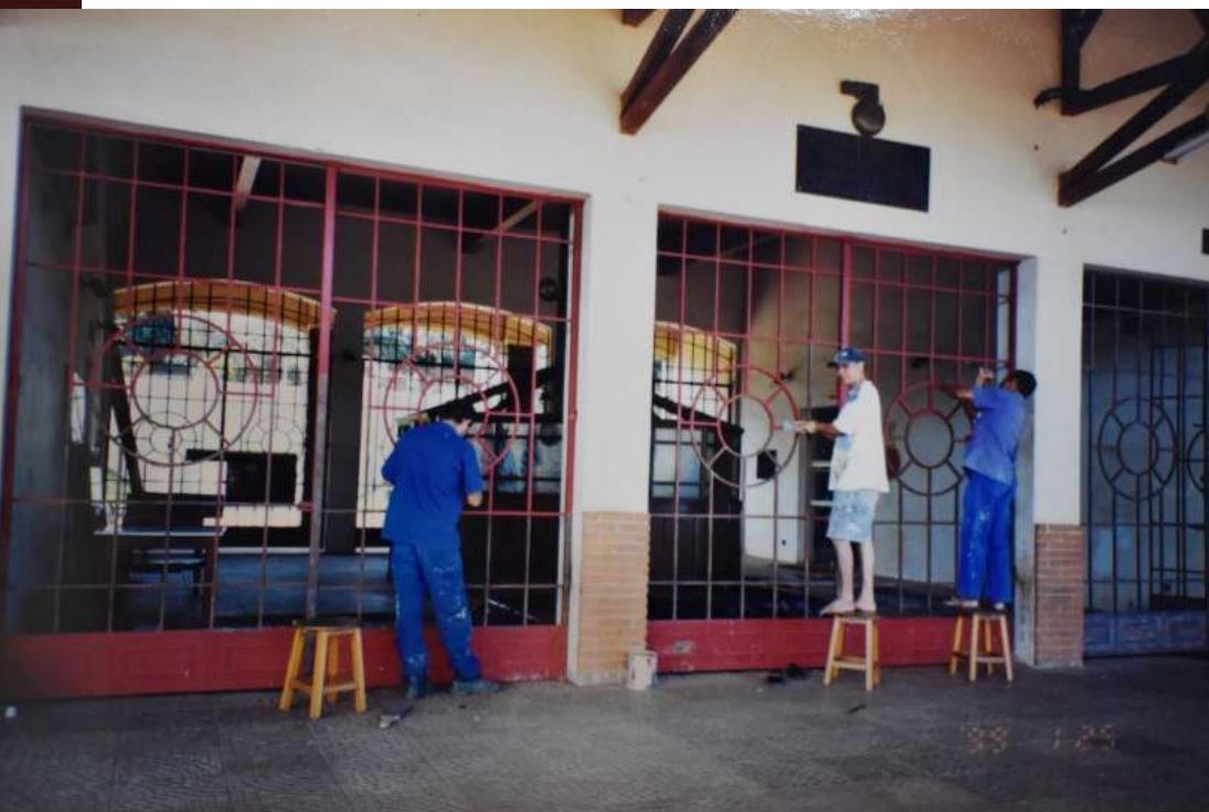
Figura 121 - Pintura dos portões metálicos, 1999.
