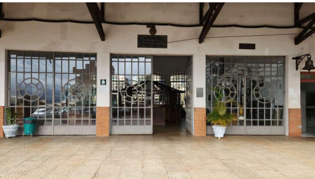
Figura 63 - Foto portão de ferro presente na fachada norte.
