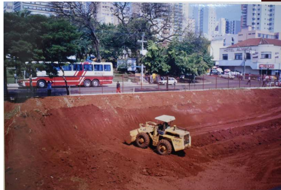
Figura 124 - Reforma do Jardim, 1998. Observa-se as grades já instaladas ao redor da quadra.
