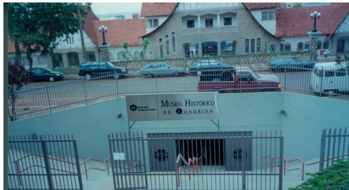
Figura 43 — Portão de entrada para o túnel na Praça Rocha Pombo.
