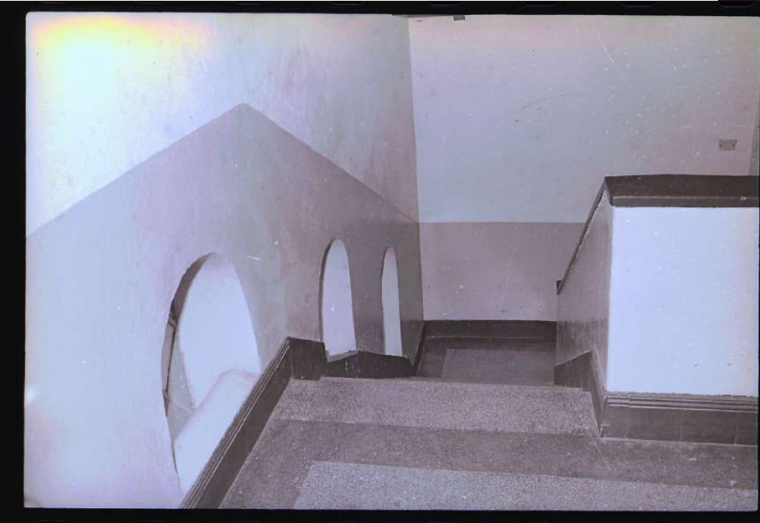
Figura 94 — Escadas de acesso ao segundo pavimento superior durante as obras de 1986.
