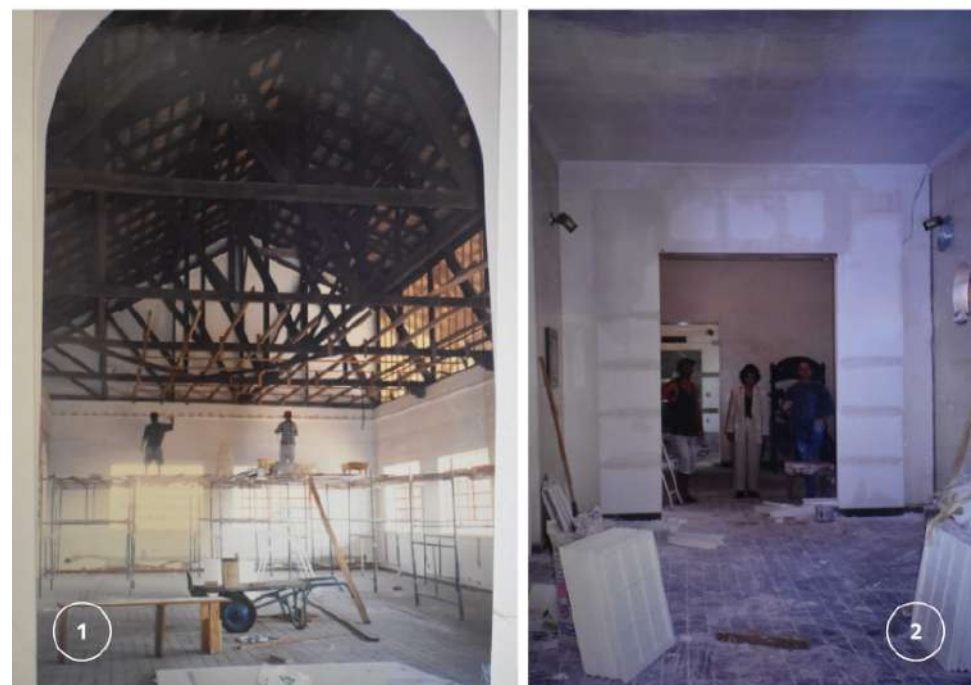
Figura 120 - Instalação do forro de gesso nas salas de exposição, 1998.
