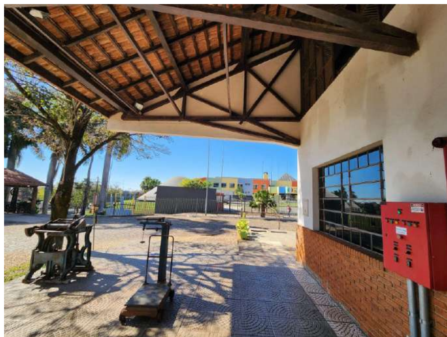
Figura 183 - Vista do MHL para a viela e Super Creche.
