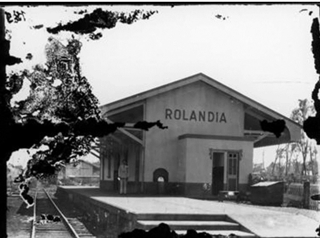
Figura 11 — Estação ferroviária de Rolândia (inaugurada em janeiro de 1936).
