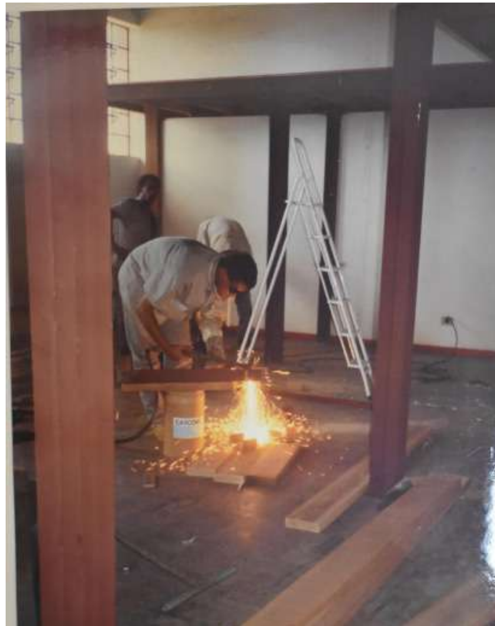
Figura 32 — Reforma do segundo pavimento, atual espaço da biblioteca.
