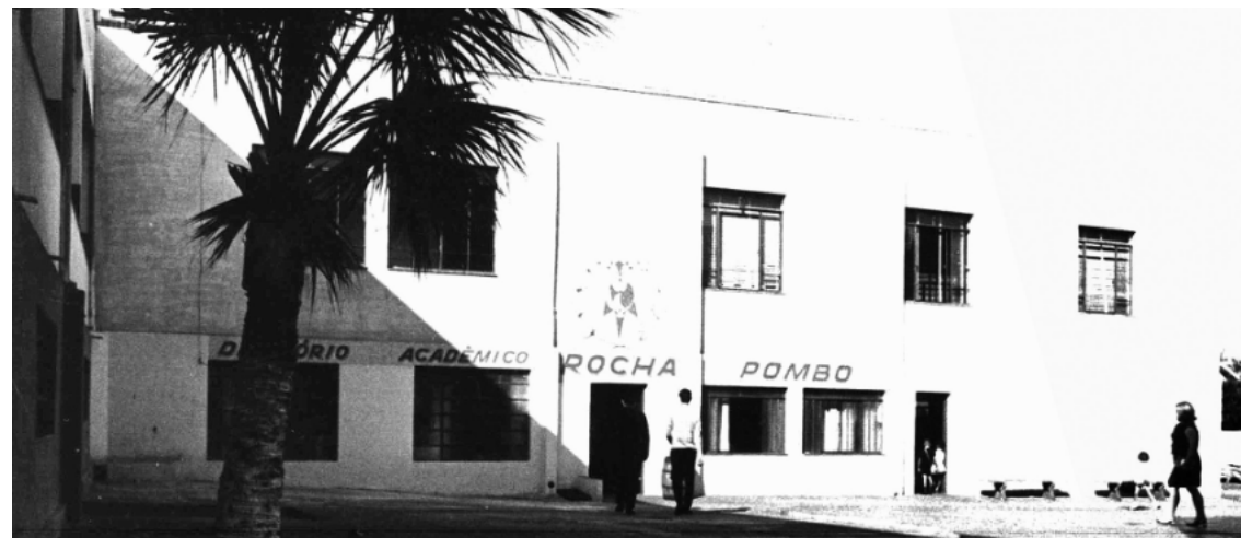
Figura 20 - Prédio do diretório Acadêmico Rocha Pombo onde também existiu o MHL (década de 1950).
