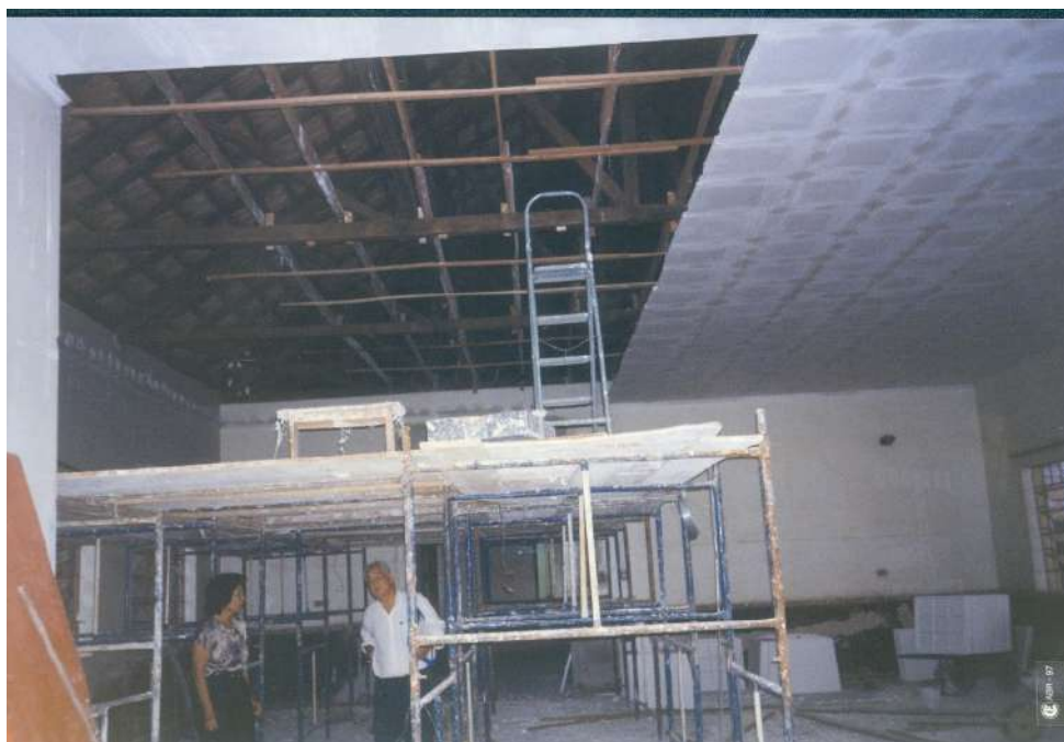
Figura 119 - Instalação do forro de gesso nas salas de exposição, 1998.
