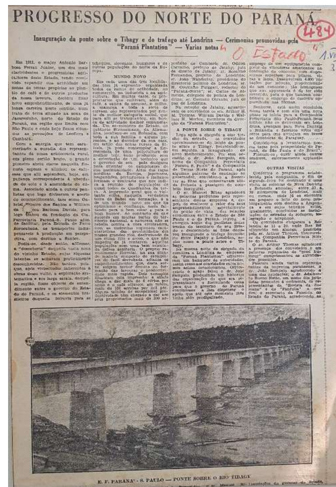
Figura 4 — Recorte da notícia acerca da inauguração da ponte ferroviária sobre o rio Tibagi - O Estado de S. Paulo (01/08/1935).
