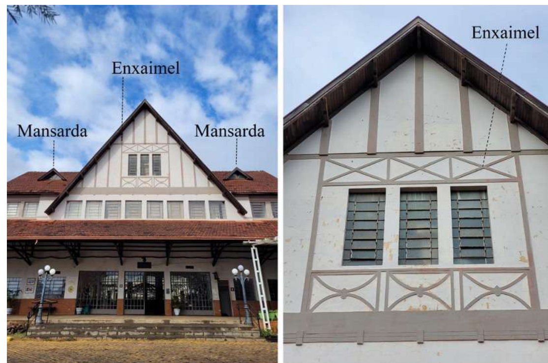
Figura 62 - Fachada onde era a plataforma de acesso a ferrovia (fachada norte) do Museu Histórico de Londrina.
