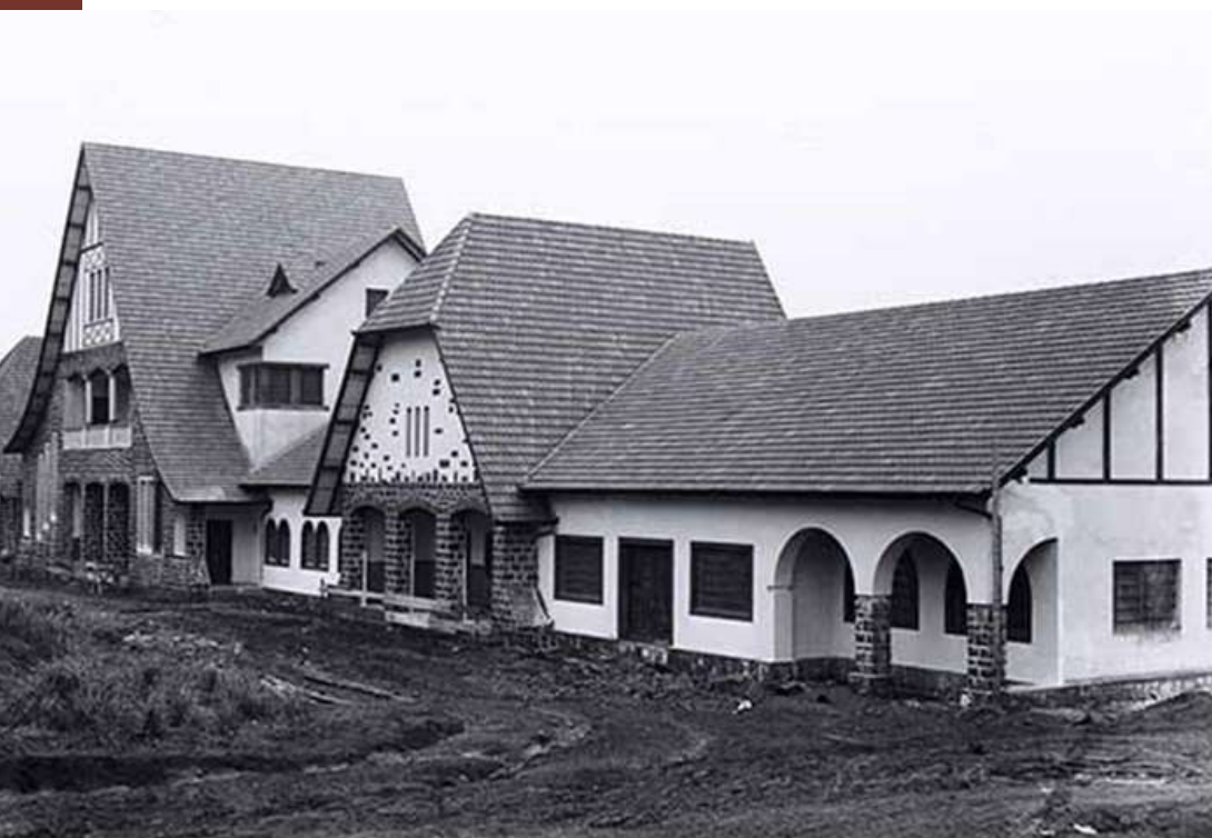
Figura 14 — Prédio da segunda estação ferroviária finalizado.
