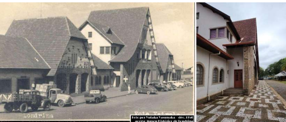
Figura 83 — Calçada da fachada da Estação Ferroviária déc. 1950 / Calçada em Petit pavé feita na obra de reuso de 1986 (Foto de 2023).
