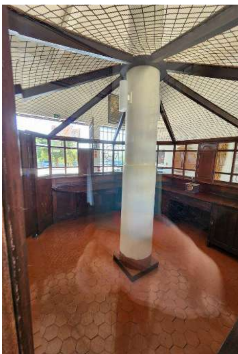
Figura 91 — Piso do piso do guichê de madeira.
