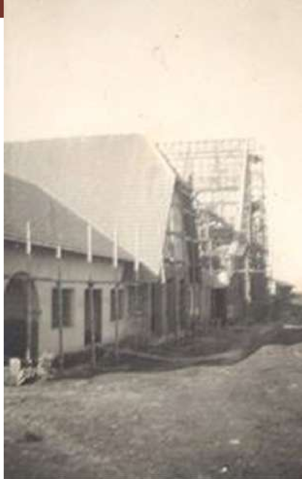
Figura 13 — Construção da segunda estação ferroviária de Londrina. Fonte: Acervo MHL (2023).
