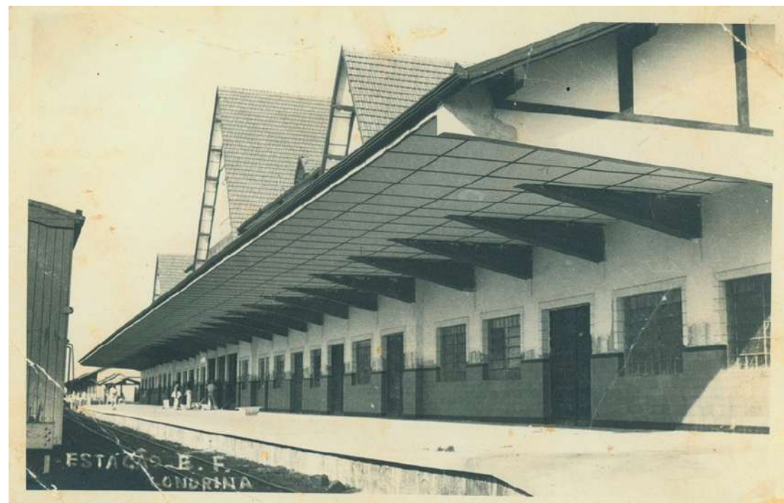
Figura 101 — Forro da gare da antiga Estação Ferroviária.
