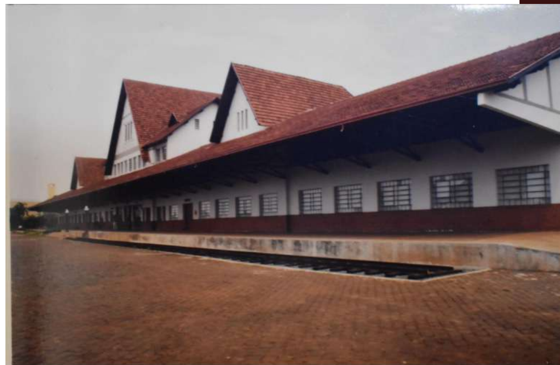
Figura 126 - Trecho refeito da linha férrea.
