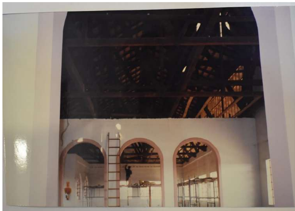
Figura 27 — Obras na parte interna da Estação ferroviária. Fonte: Acervo MHL (2023).
