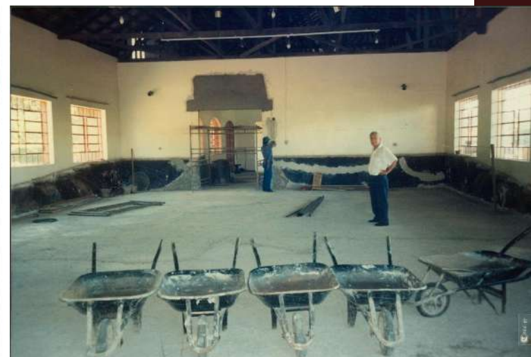
Figura 122 - Retirada do auditório, 1997. Observa-se nas paredes as marcas do piso elevado do auditório.
