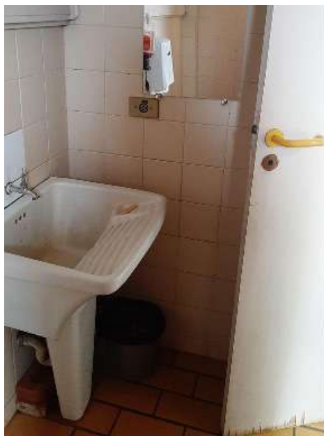
Figura 95 — Banheiro do segundo pavimento superior - situação atualmente.
