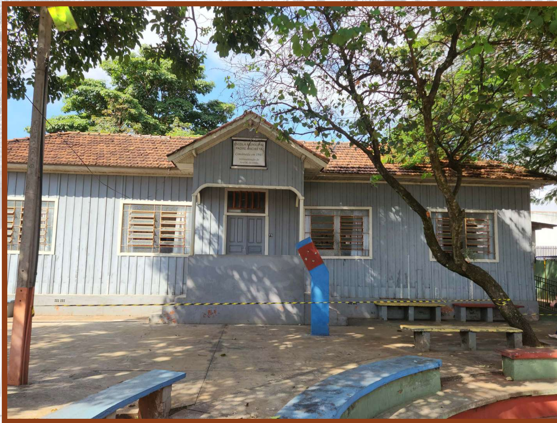
Figura 1 - Escola Municipal Padre Anchieta. Prédio de madeira.
