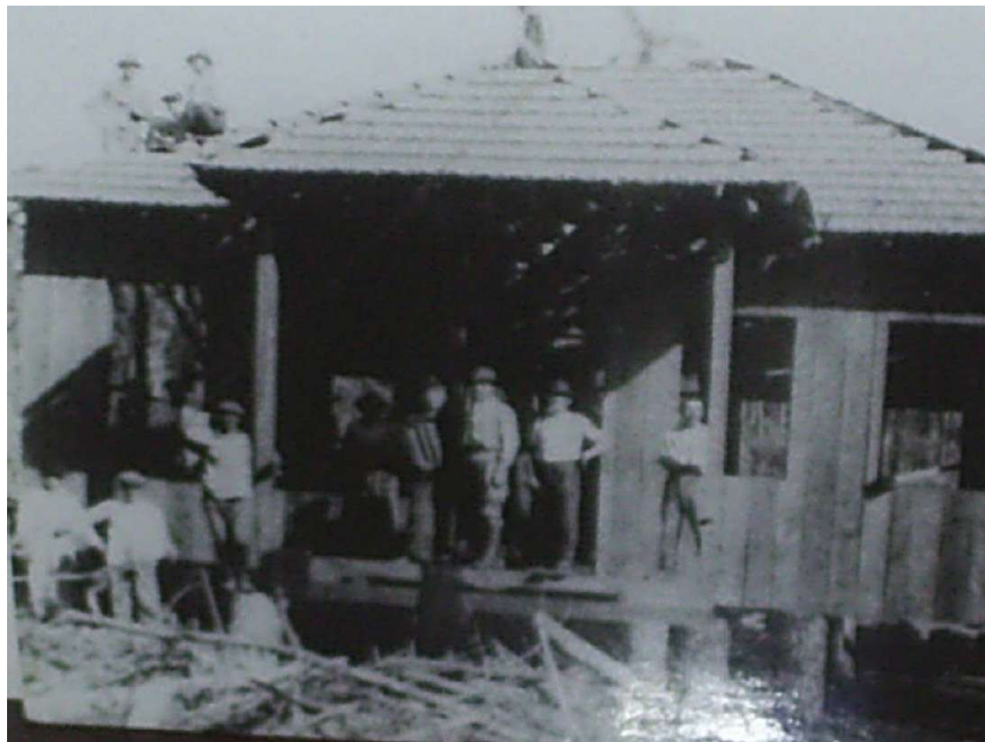
Figura 4 - Escola Alemã sob construção pelos colonos da região.
