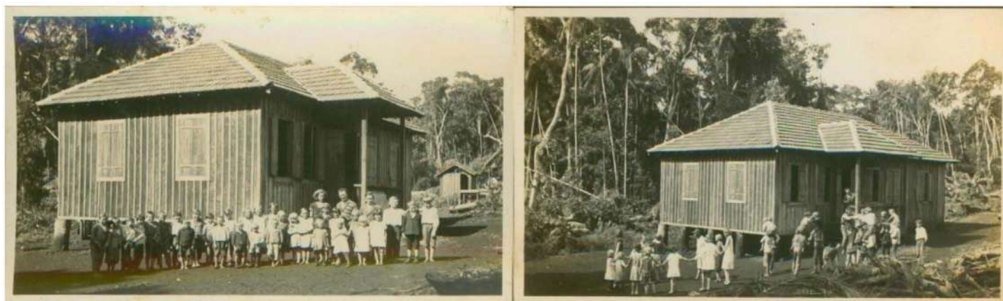
Figura 54 - Comparação fotos da Escola e edifícios em volta.
