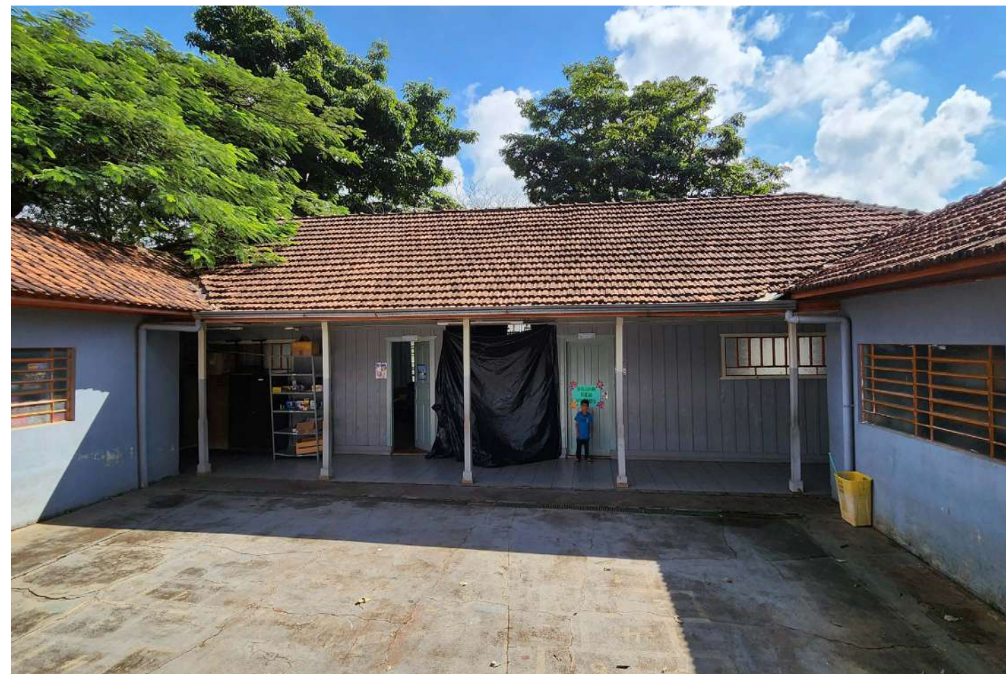
Figura 84 - fachada dos fundos da Escola Municipal Padre Anchieta.
