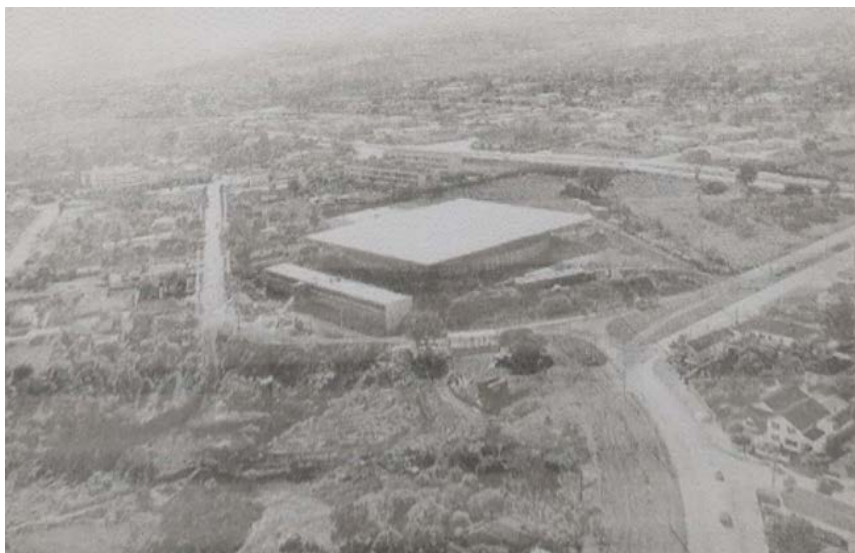
Figura 6– Foto aérea panorâmica que mostra o espaço onde hoje é o Zerão sendo modificado.
