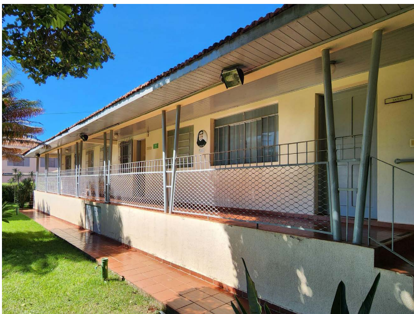
Figura 14- Varanda e porta de acesso
