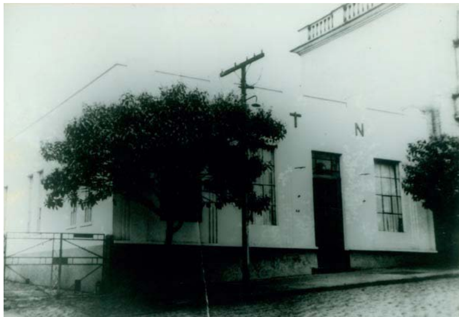
Figura 10 - Fachada da Central Telefônica Nacional– CTN, 195-
