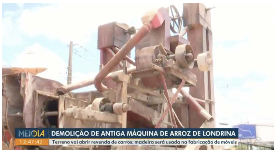
Figura 18 - Demolição do Armazém Máquina de Arroz Londrina, 2022.
