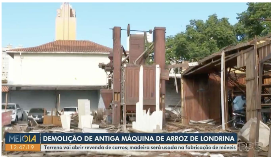
Figura 19 - Demolição do Armazém Máquina de Arroz Londrina, 2022.
