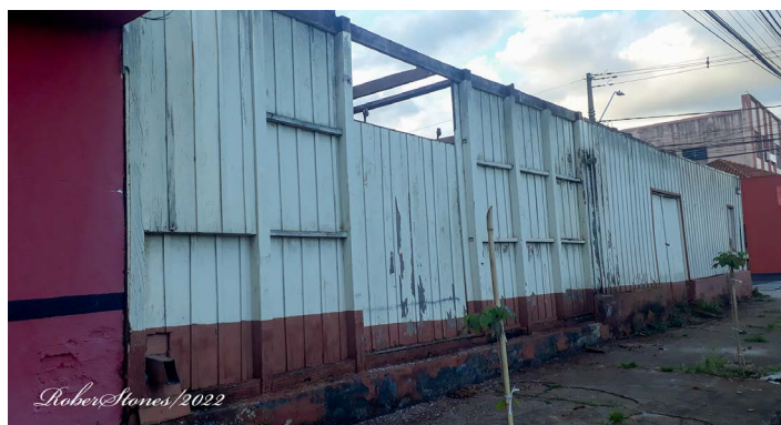
Figura 15 - Demolição do Armazém Máquina de Arroz Londrina, 2022.
