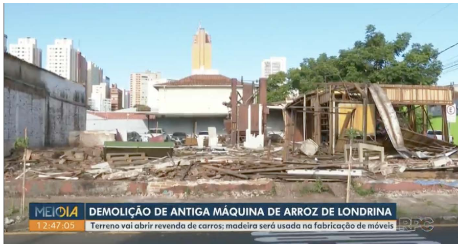
Figura 20 - Demolição do Armazém Máquina de Arroz Londrina, 2022.
