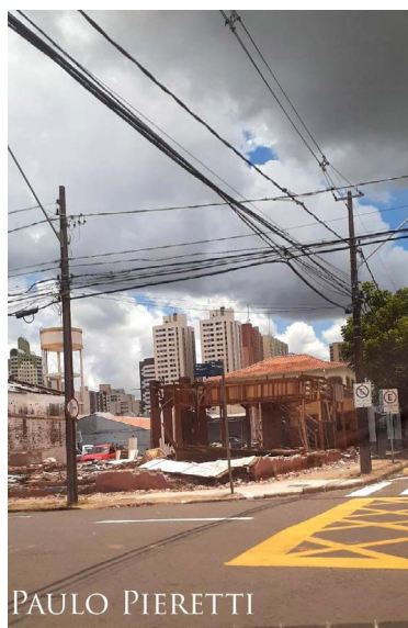
Figura 21 - Demolição do Armazém Máquina de Arroz Londrina, 2022.
