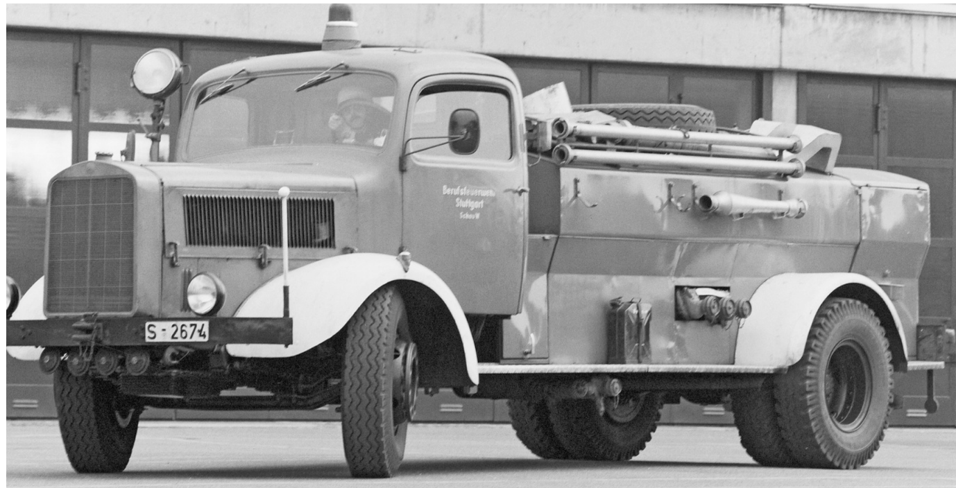
Figura 20 - Mercedes-Benz L 4500 F (L 303), caminhão dos bombeiros de Stuttgart com motor OM 67/4, construído em 1944.
