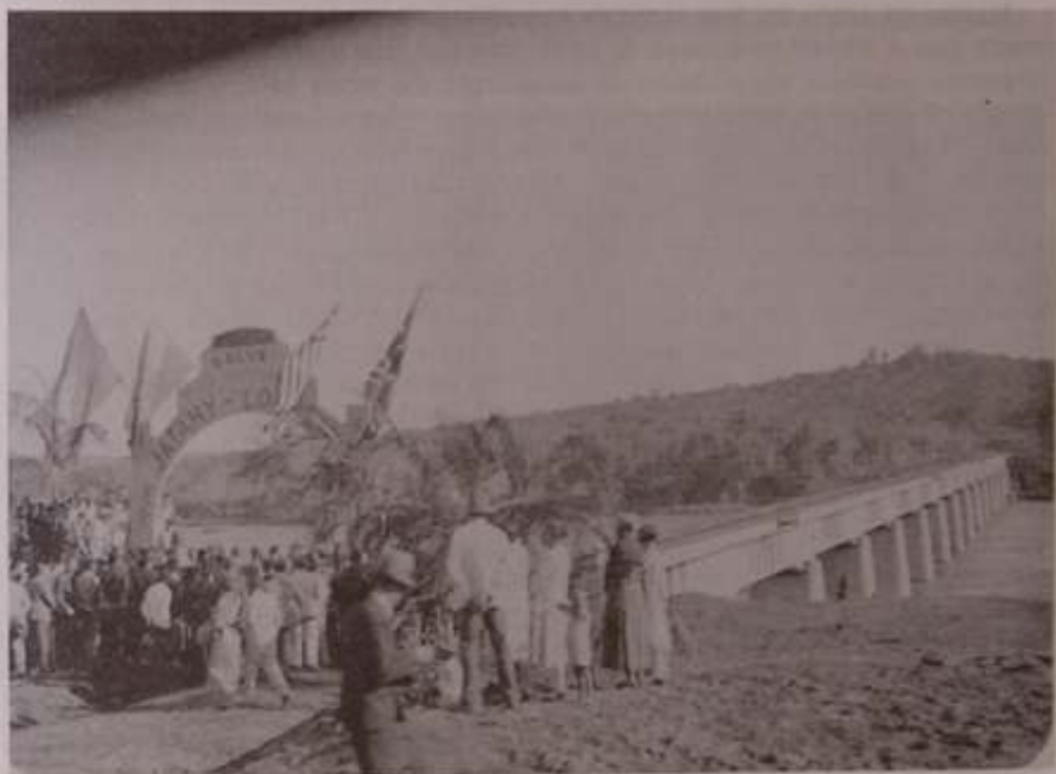
Inauguração da ponte sobre o Rio Tibagi
