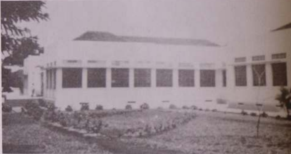
Aspecto do Grupo Escolar Hugo Simas, vendo-se a área onde seria construído anexo destinado à Faculdade de Direito
