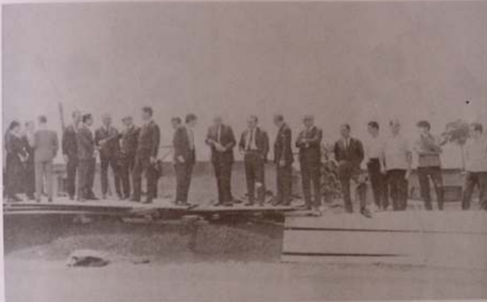
Autoridades e fundadores da Faculdade de Medicina, visitando as obras de construção, em seu início
