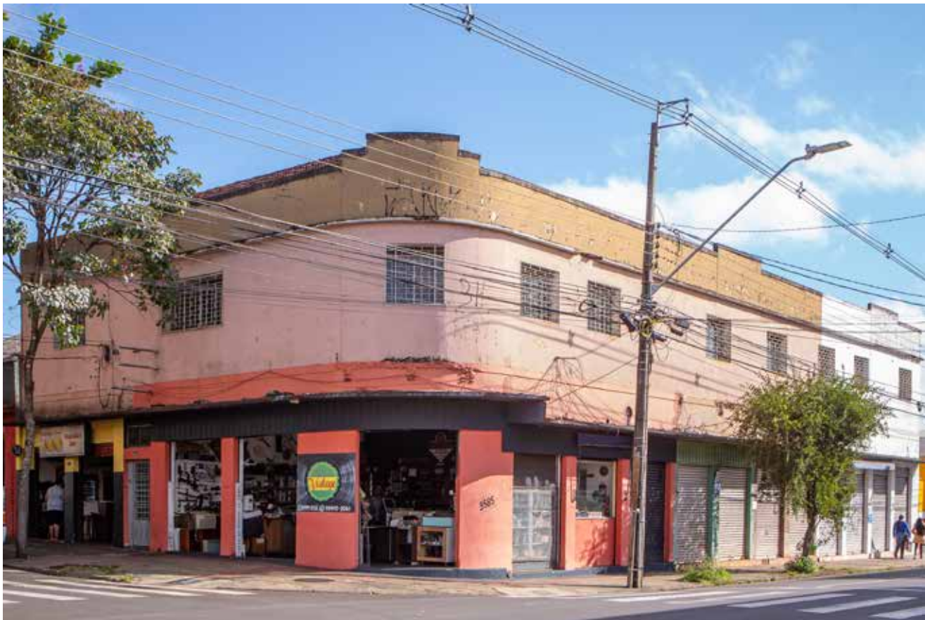
Edificação da década de 1940 com filiação ao Art Déco Streamline , onde funcionou as Lojas Riachuelo nos anos de 1950 Foto: Rei Santos | 2021
