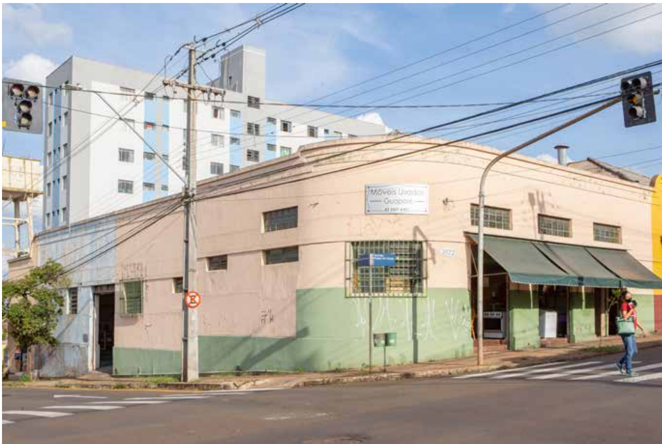
Edificação da década de 1940 com características do Art Déco Streamline . Aqui funcionou o Armazém Dias Martins Foto: Rei Santos | 2021
