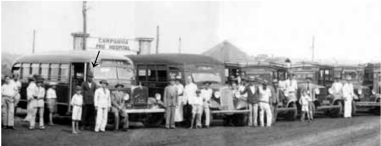
Terreno onde seria construída a Santa Casa. O Dr. Clímaco com doadores e voluntários.
